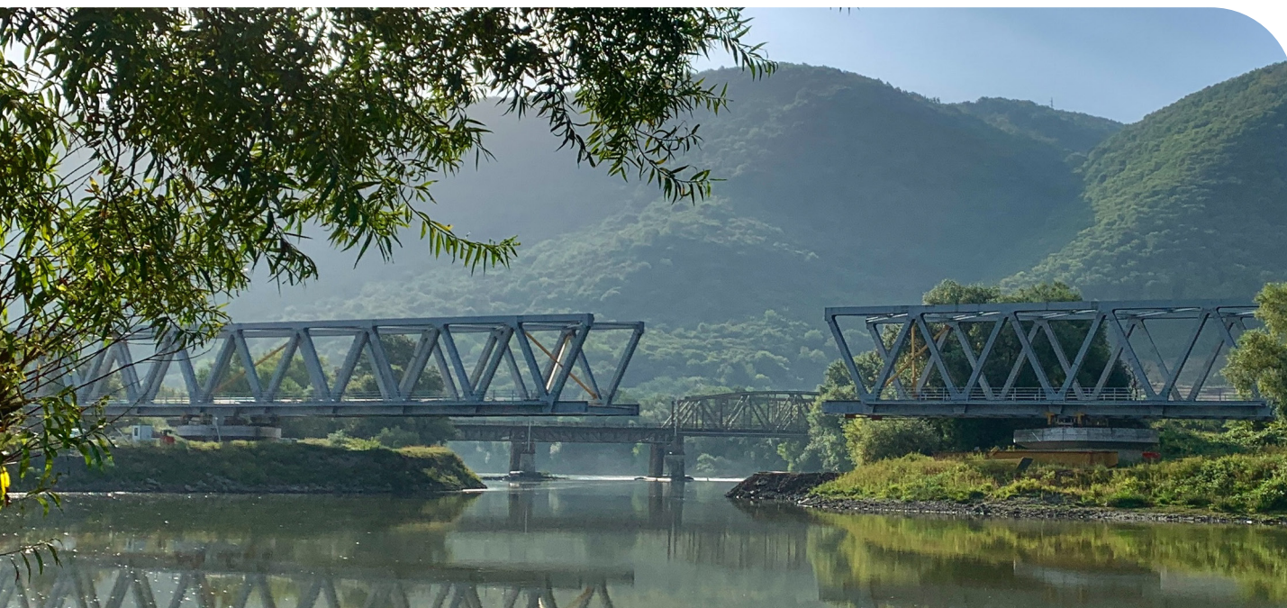
Ponte Ferroviária Mures – Romênia
