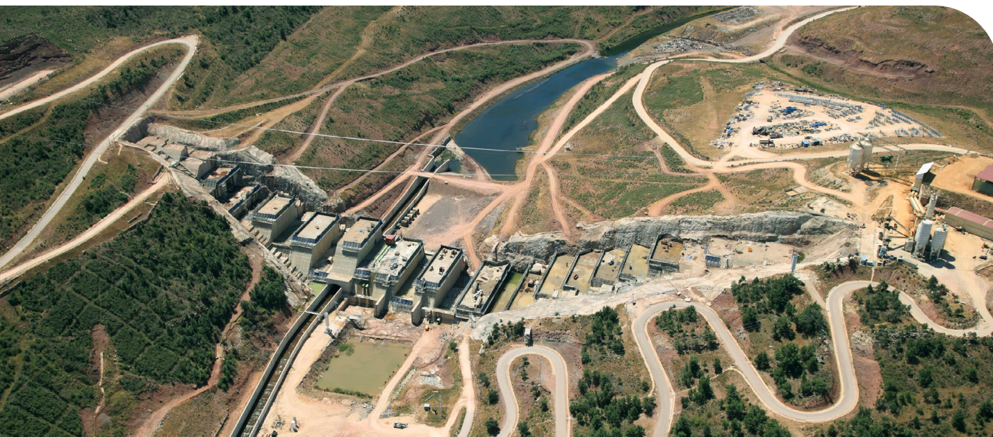
Barragem de Castrovido - Espanha
