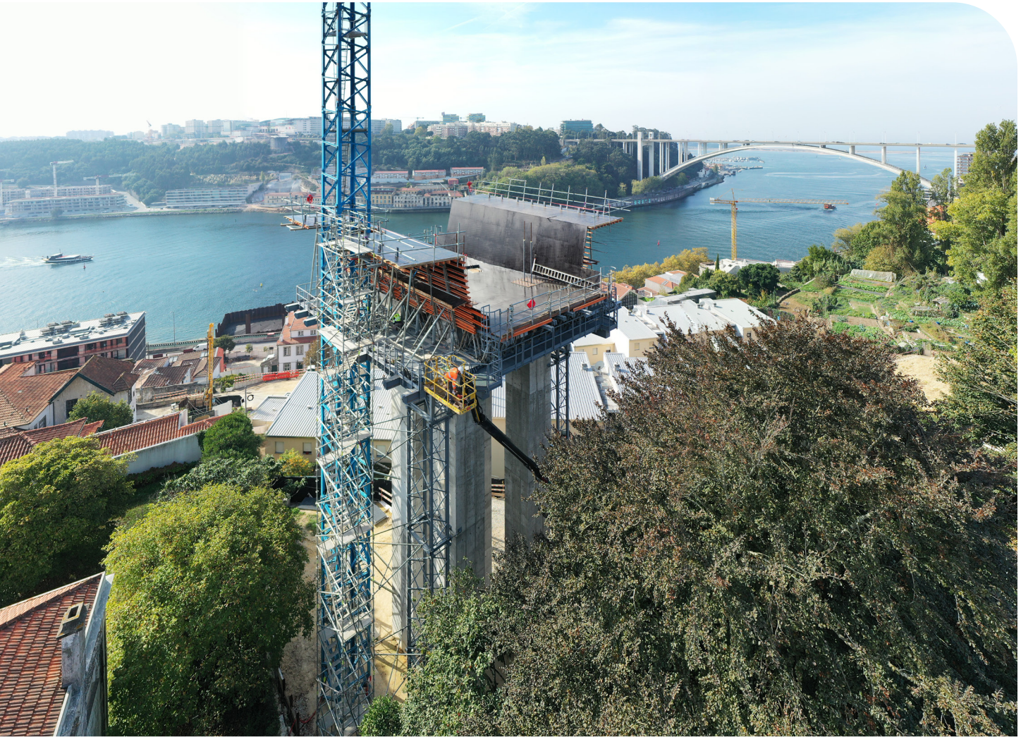
Linha Rubi do Metro do Porto – Ponte Ferreira – Portugal
