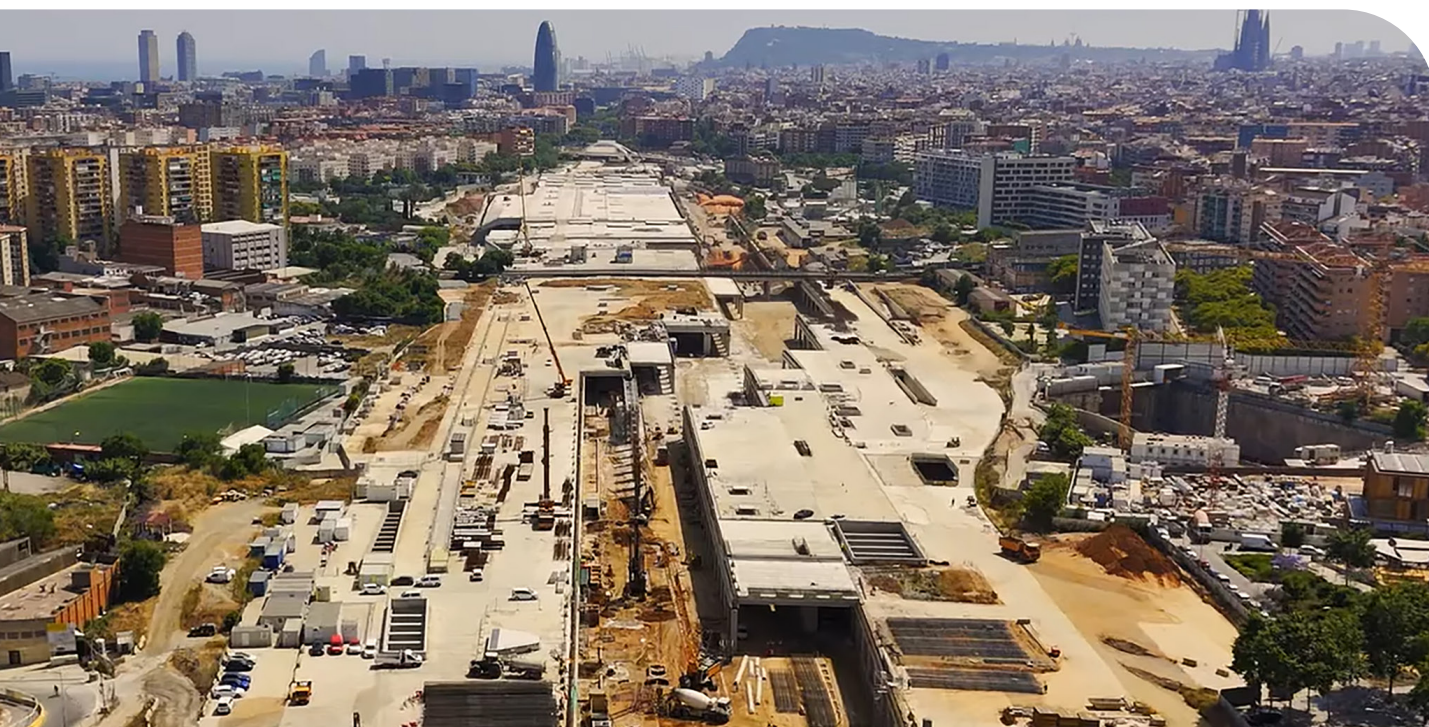
Acessos ferroviários à estação La Sagrera – Espanha
