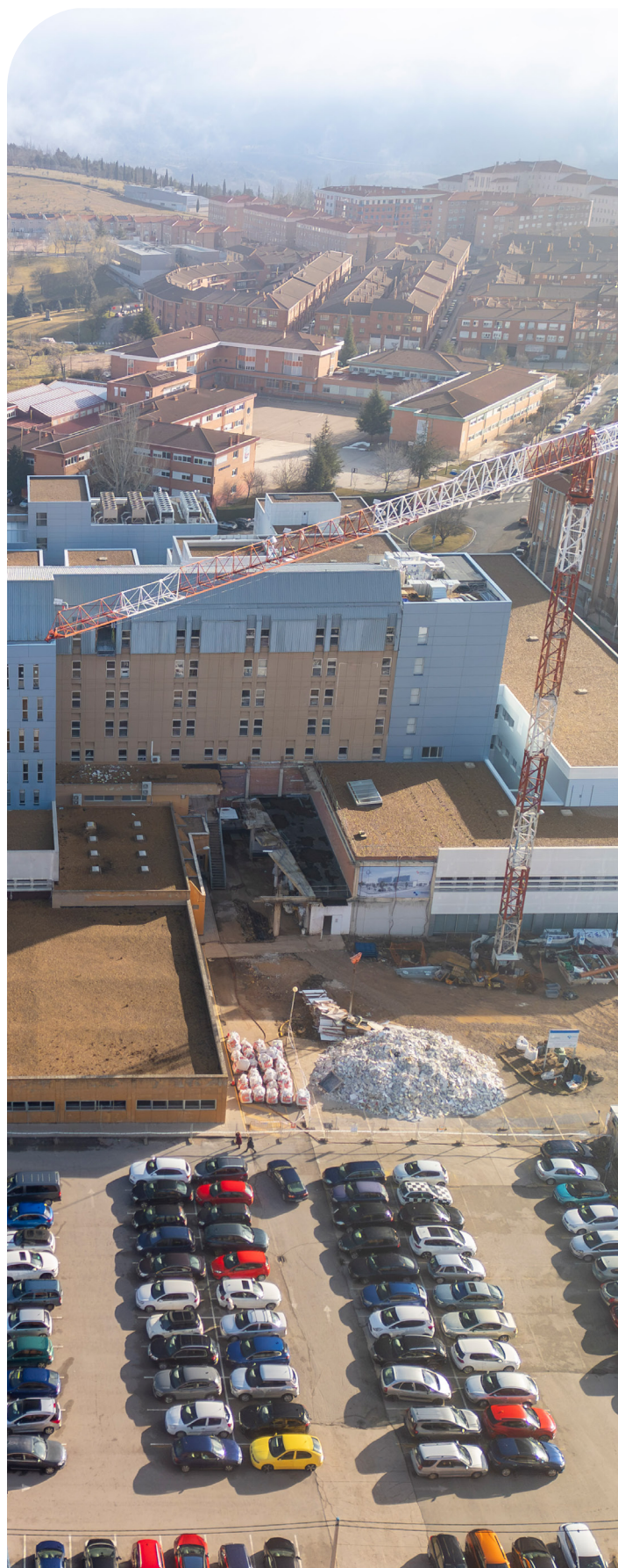
Renovarea și extinderea Spitalului din Soria – Spania
