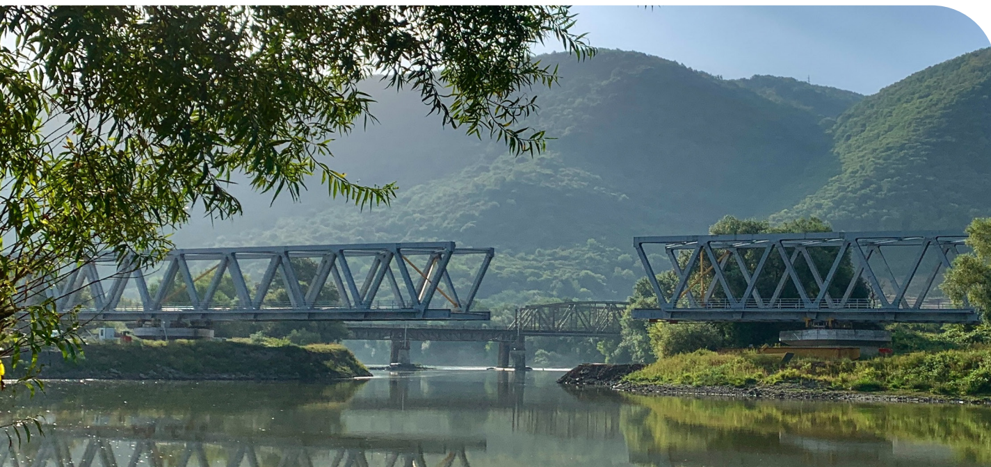
Puente Ferroviario Mures - Rumanía
