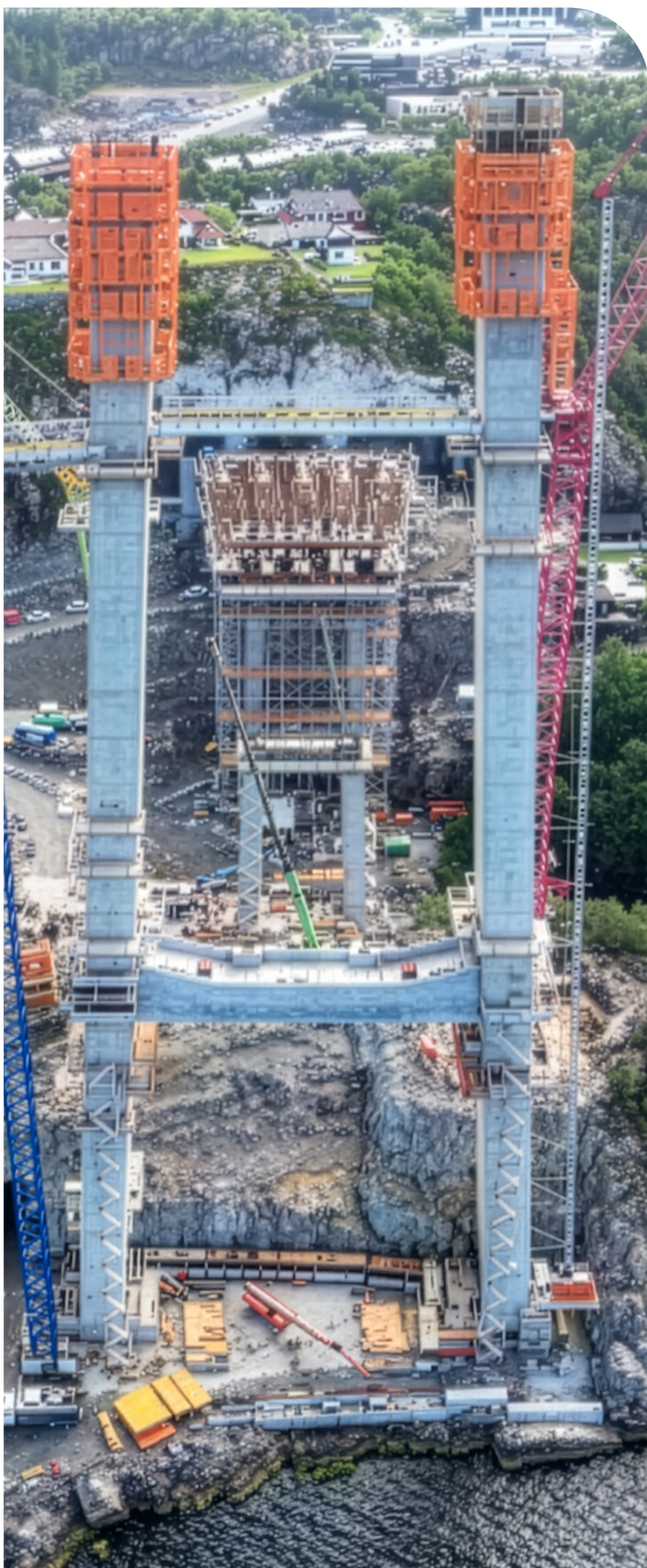
Sotra Bridge – Noruega
