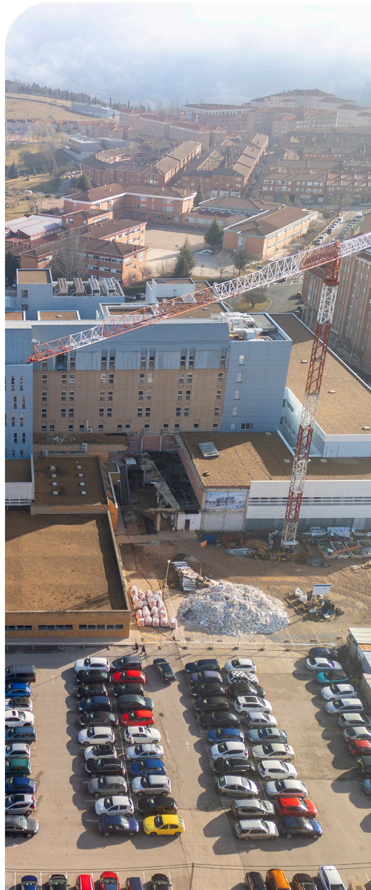
Reforma y ampliación del Hospital de Soria - España
