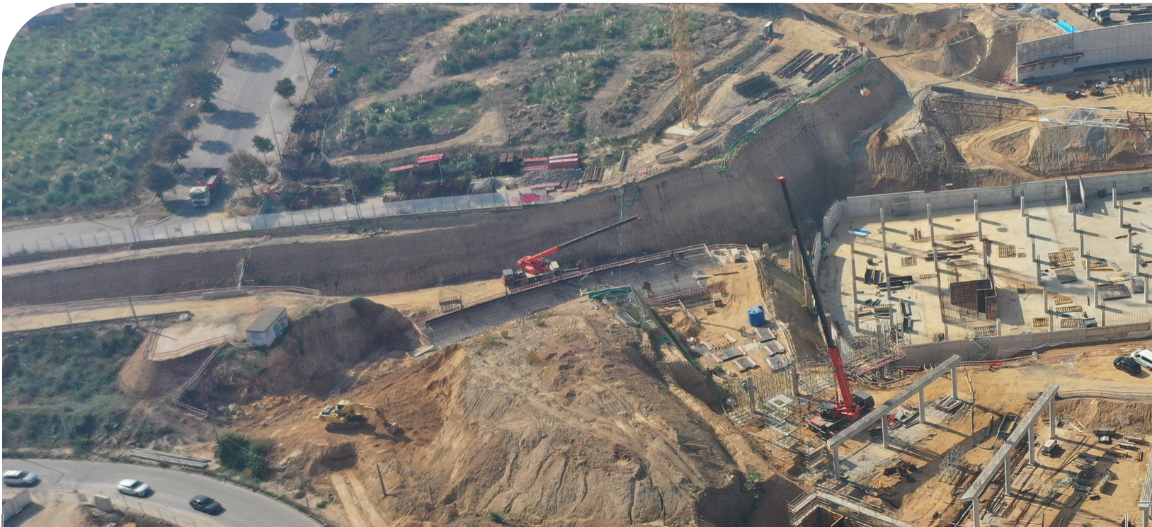
Nueva estación de Metro Línea Rubi-Oporto - Portugal
