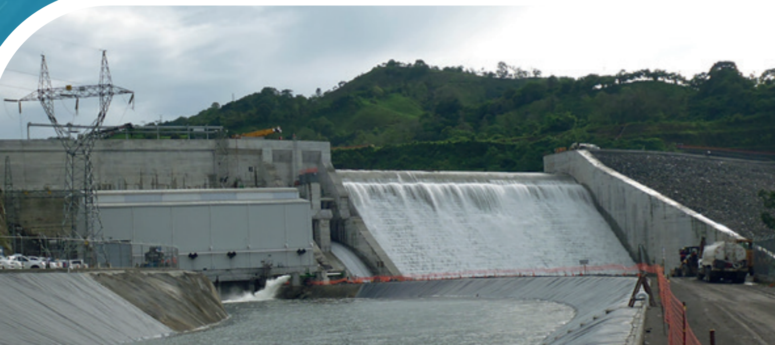
Bajo Frío Dam - Panama
