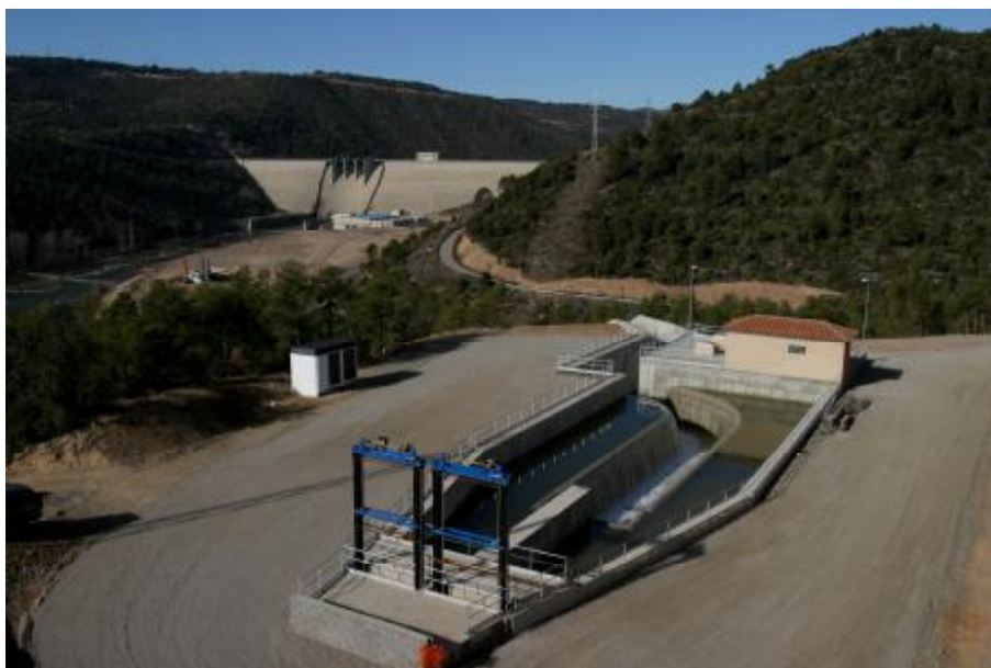
Figura 9. Cuenca amortiguador previo al Canal Segarra-Garrigues
