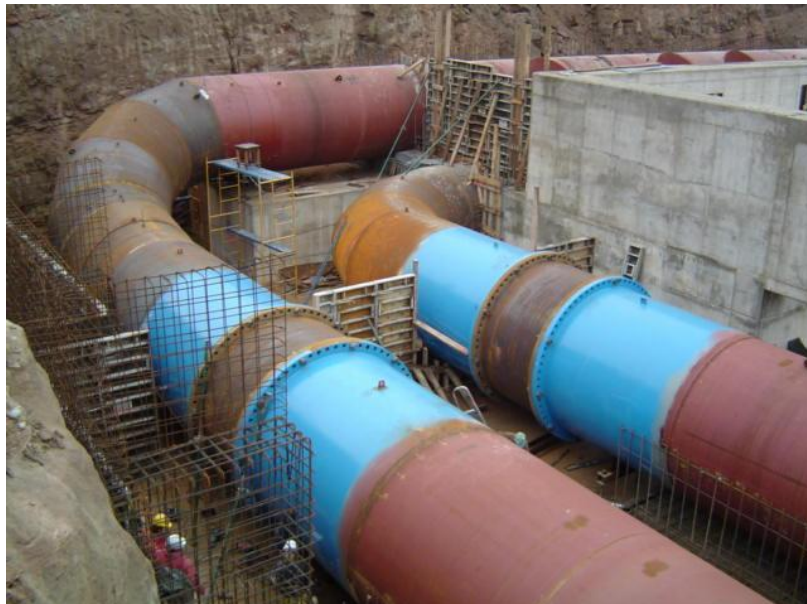
Figura 6. Ejecución del By-pass de la estación de Bombeo
