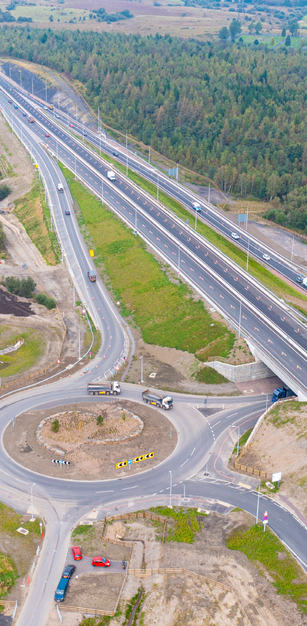
Lărgirea autostrăzii A-465 (Țara Galilor, Regatul Unit)
