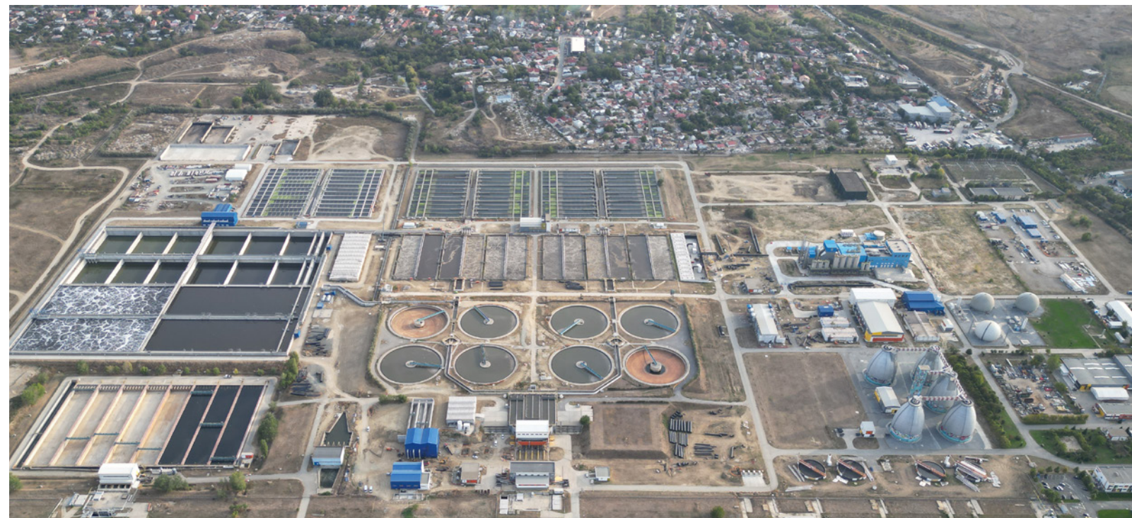
Stația de tratare a apelor reziduale Glina (România)
