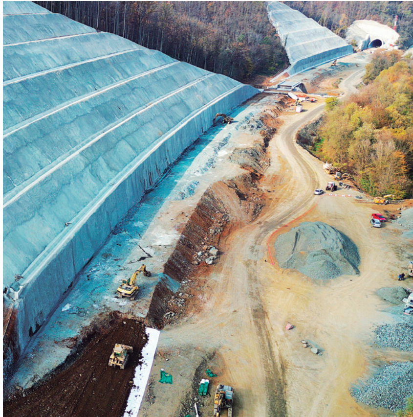
Construcția a diverse tronsoane de cale ferată (România)
