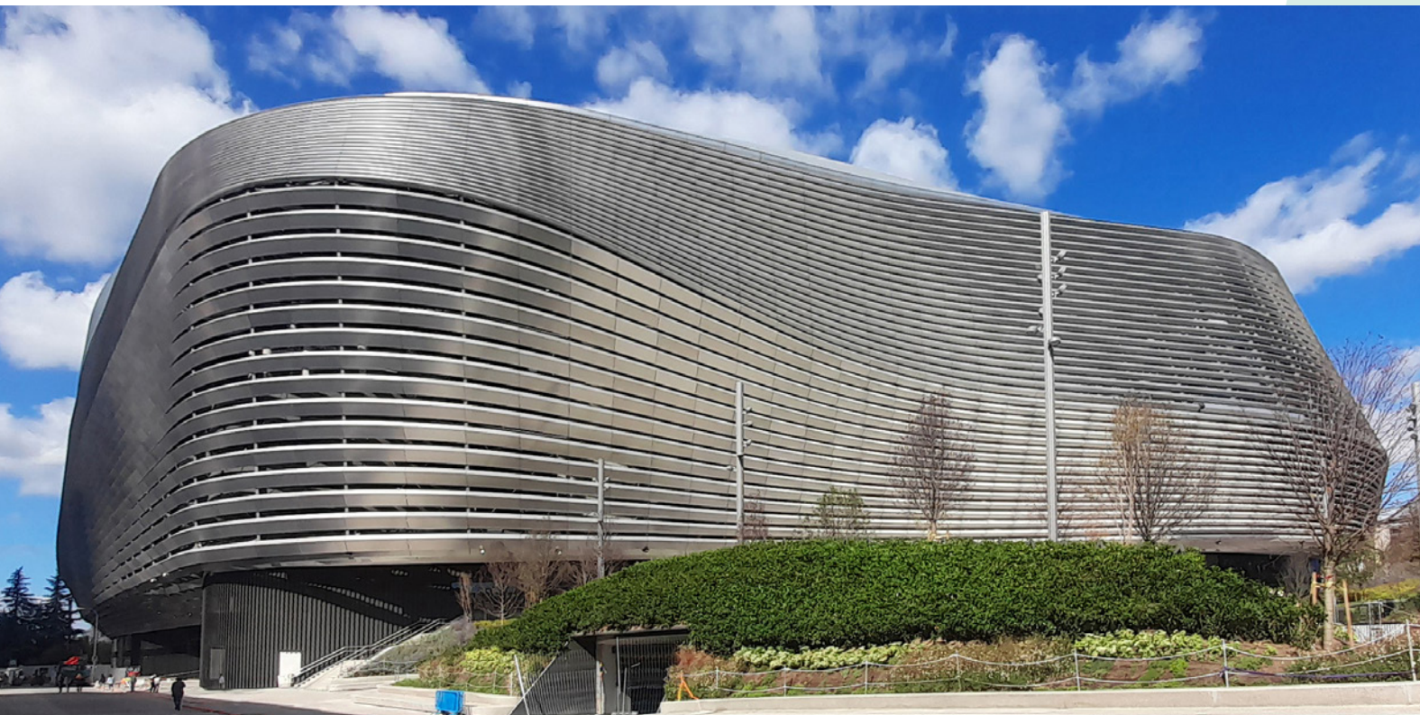
Remodelarea stadionului Santiago Bernabeu (Madrid, Spania)
