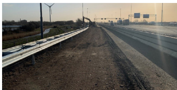
Extensión del material reciclado en la A9.
