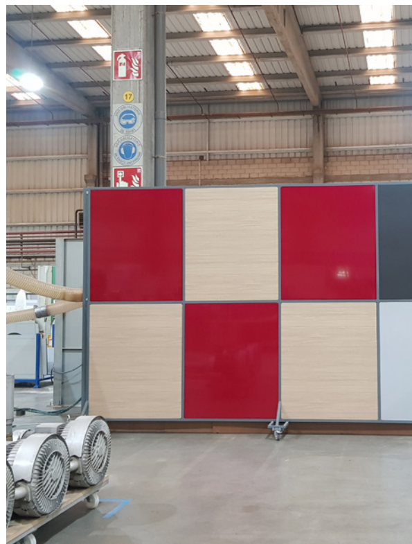
Paneles acústicos instalados para atenuar las emisiones acústicas en las áreas aledañas al uso de la fresadora.
