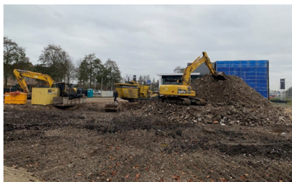
Acopio del material e inicio de la fase de trituración.
