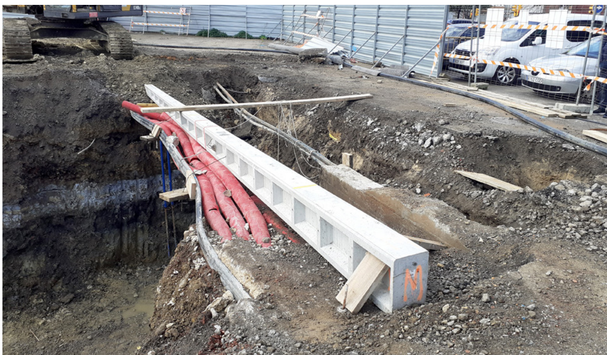
Detalle del apuntalamiento de forma provisional de los servicios afectados para su protección.
