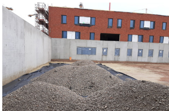
Zahorras dispuestas para ser extendidas en el patio exterior de la prisión.
