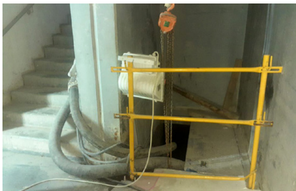
Las tuberías dirigen el agua a través de los niveles del eje hasta el nivel del suelo.
