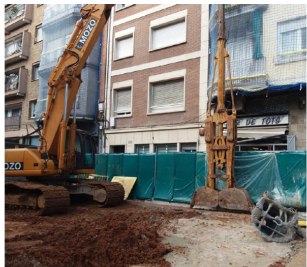
Vista general de los paneles de insonorización en obra. Estación de Metro de Maragall (Barcelona).
