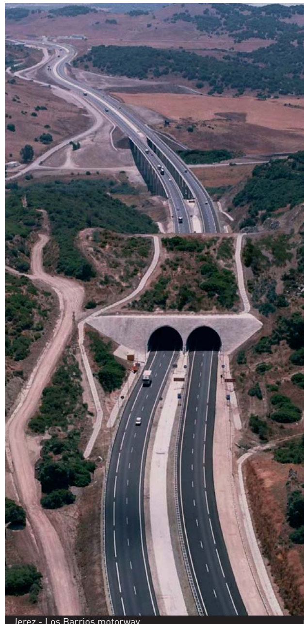
Jerez - Los Barrios motorway
