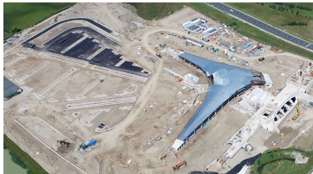
Toronto metro project (Canada).
