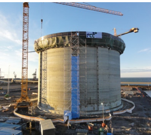
LNG storage tank, Finland
