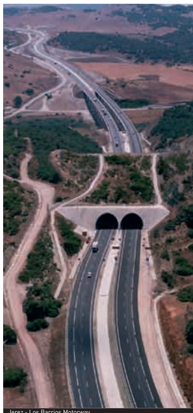
Jerez - Los Barrios Motorway
