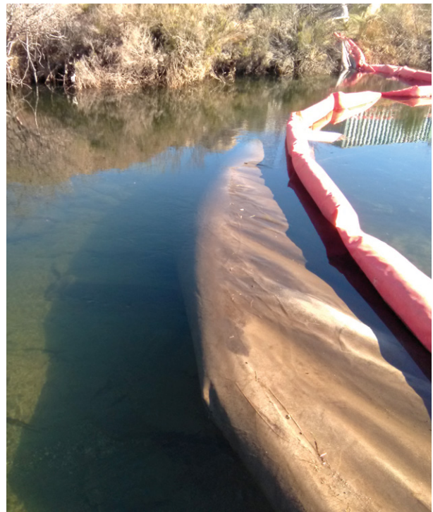
La barrera consta de una parte flotante y otra anclada al fondo que embalsa el agua turbia y la filtra.
