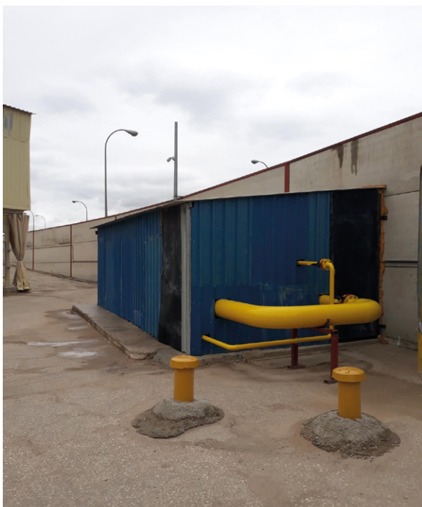
Tuberías de suministro de gas natural en la planta de fabricación de aglomerado de Vicálvaro.
