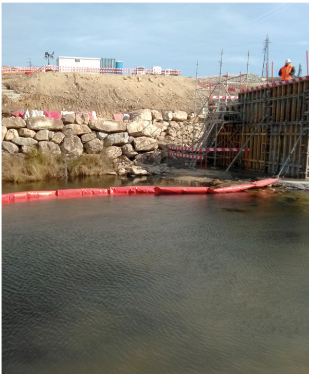
La barrera de geotextil retiene partículas en suspensión alrededor de la zona de obra.
