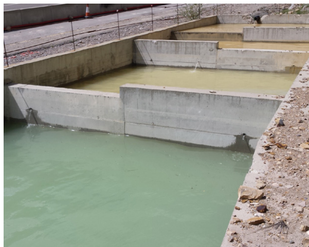
Las balsas secuenciadas permiten decantar los sólidos en suspensión antes de verter las aguas al río.
