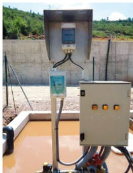
Centralita para el control de pH, regulando la inyección de CO 2 y balsa de captación de aguas para posterior tratado con CO 2
