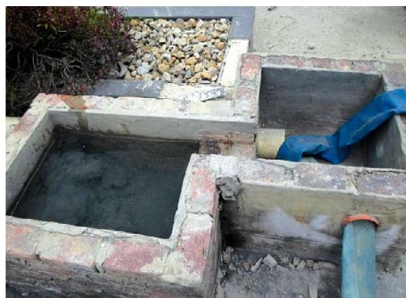
Incorporación del vertido a la red de alcantarillado
