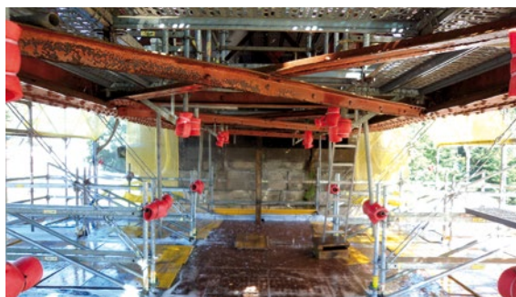
Lavado de la estructura metálica del viaducto
