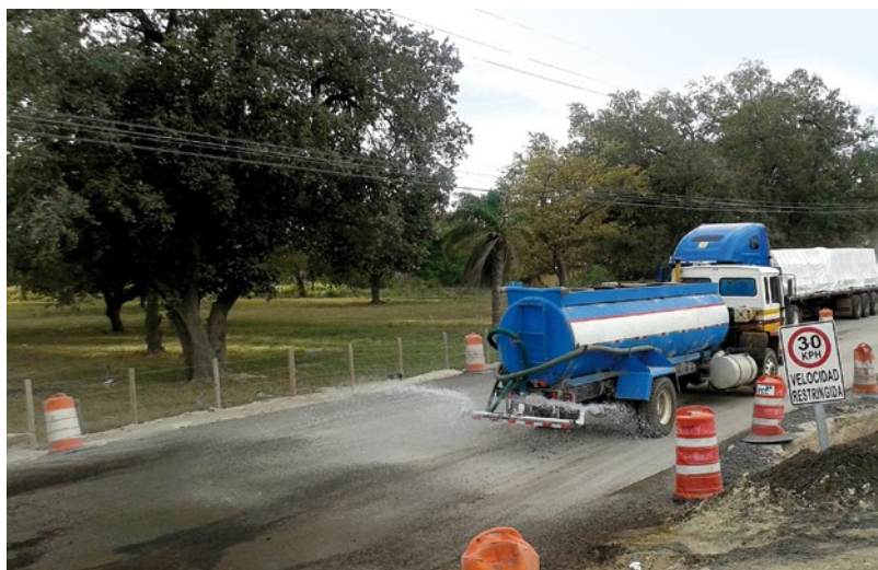
Riego de caminos, uso de lonas para el transporte de materiales y limitación de la velocidad
