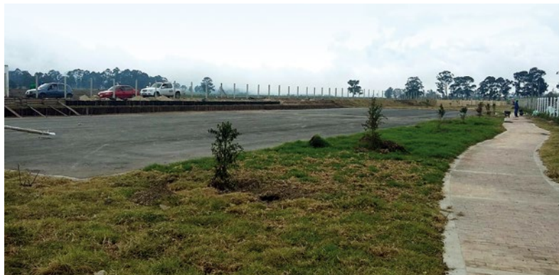
Construcción del Parque San Nicolás
