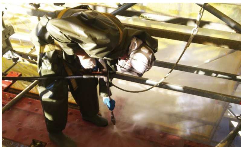
Lavado de la estructura metálica del viaducto
