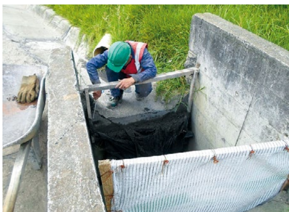
Desarenador de las aguas procedentes de lluvia y escorrentía
