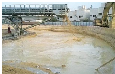
Colector de material extraído por las tuneladoras de la línea 5
