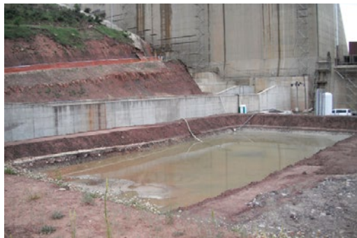
Centralita para el control de pH, regulando la inyección de CO 2 y balsa de captación de aguas para posterior tratado con CO 2
