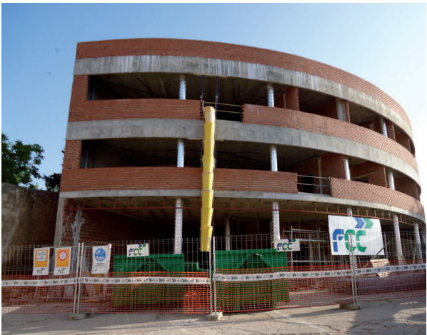
➤ Acciones sencillas y fáciles de aplicar como la cubrición de los camiones que transportan material pulverulento o el empleo de trompas para el vertido de escombros desde altura disminuyen considerablemente la generación de polvo en las obras.
