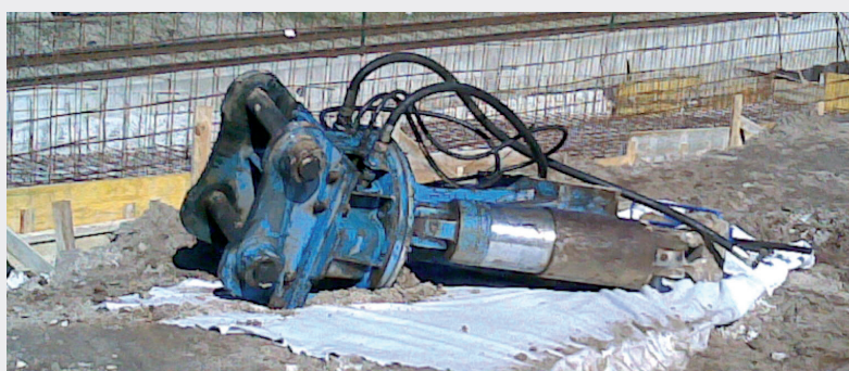
Protección del suelo sobre el que se deposita maquinaria.
