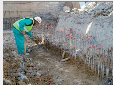
Limpieza de lodos bentoníticos de los muro pantalla adyacentes.
