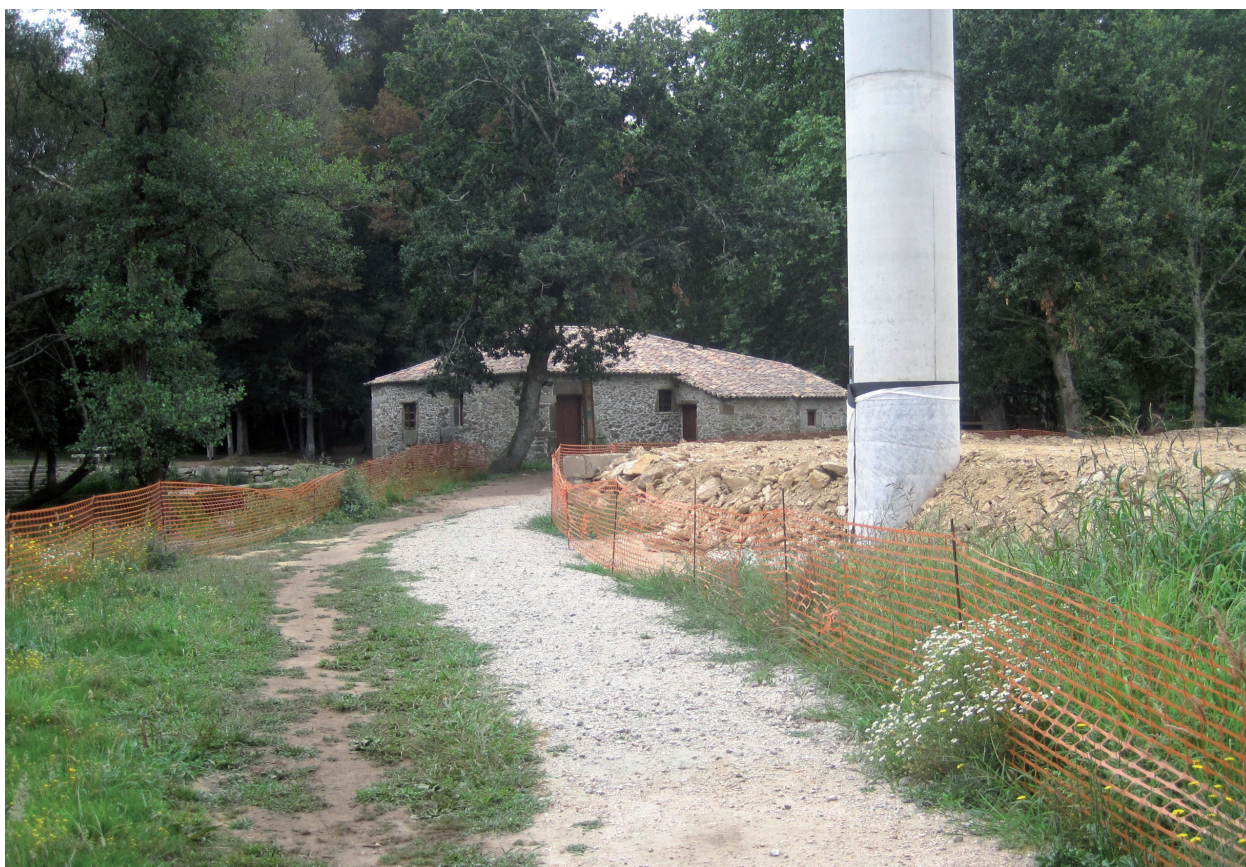
► La delimitación de las áreas sensibles del entorno de nuestras obras, minimiza su ocupación y la consecuente compactación y posible contaminación del suelo.
