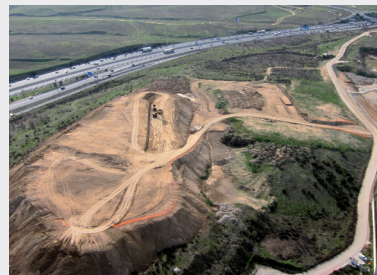
Máquinas extrayendo tierra para los rellenos de la cimentación.
