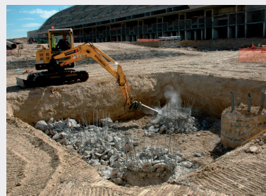
El proyecto contemplaba la excavación de cada encepado, lo cual dificultaba los trabajos de descabezado, ferrallado y encofrado de los mismos.
