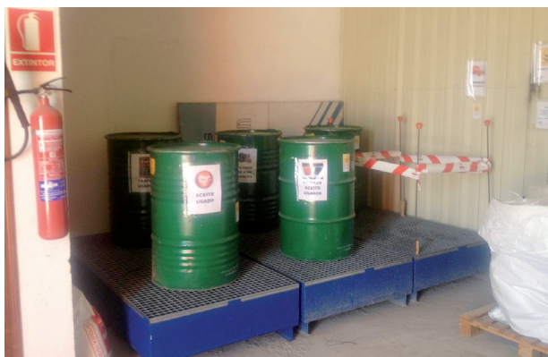
► El conocimiento de la cantidad y tipo de residuos generados en cada obra es fundamental para su correcto almacenamiento y posterior gestión. Para los residuos peligrosos se han de acondicionar zonas especiales dotadas de sistemas que impidan la contaminación del terreno o de las aguas, en caso de posibles derrames. Todas las obras de FCC Construcción aplican Buenas Prácticas orientadas a minimizar la generación de residuos y a garantizar el correcto almacenamiento de los mismos.
