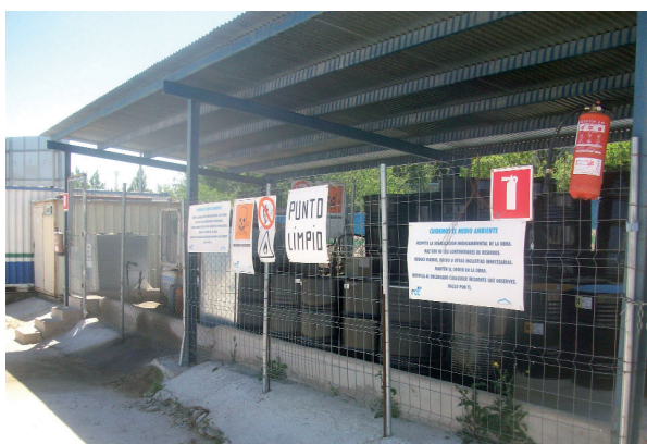
➤ Los recipientes para almacenamiento de sustancias y residuos peligrosos han de estar claramente identificados con el pictograma y etiqueta correspondiente.
