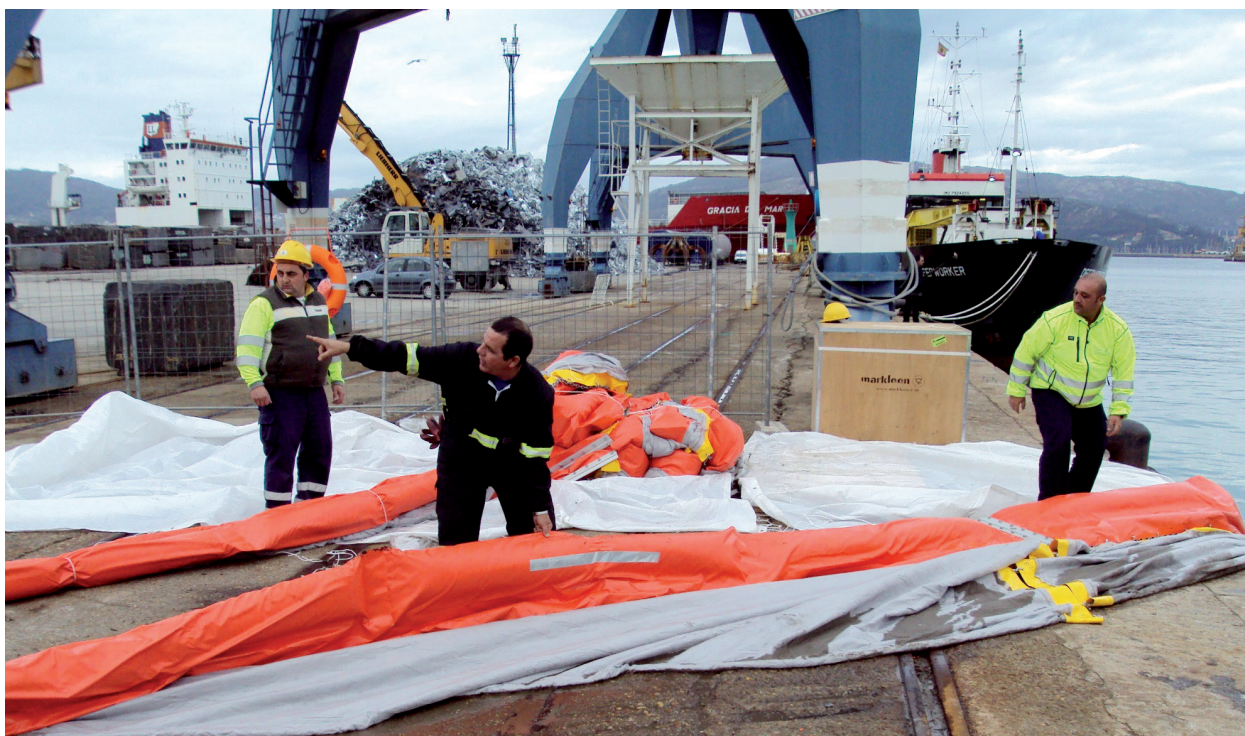
► El empleo de pantallas de geotextil minimiza el incremento de la dispersión de finos y separa, por flotación, otras sustancias en emulsión como aceites o hidrocarburos, lo que previene la contaminación de las aguas próximas.
