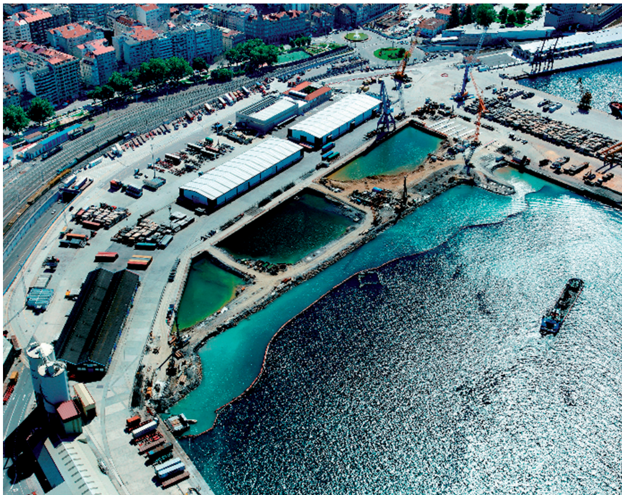
> Las barreras anti-turbidez son muy utilizadas en las obras que requieren de trabajos de dragado o de movimiento de tierras en el mar, ríos o lagos. De esta forma se preserva el medio de la turbidez provocada por los sedimentos.
