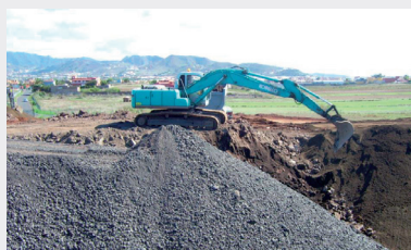
Acopio de fresado de aglomerado asfáltico.
