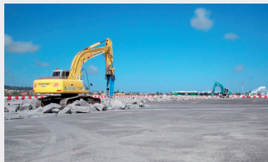
Demolición de losas de hormigón de la plataforma.
