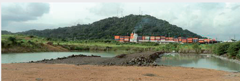
División de la balsa, el dique central actúa como filtro.
