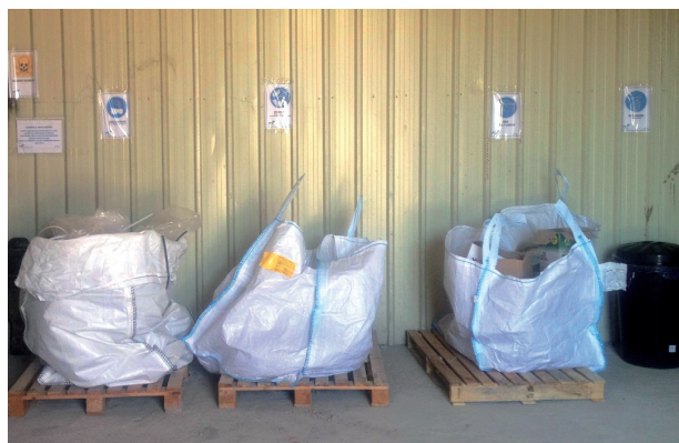
► El conocimiento de la cantidad y tipo de residuos generados en cada obra es fundamental para su correcto almacenamiento y posterior gestión. Para los residuos peligrosos se han de acondicionar zonas especiales dotadas de sistemas que impidan la contaminación del terreno o de las aguas, en caso de posibles derrames. Todas las obras de FCC Construcción aplican Buenas Prácticas orientadas a minimizar la generación de residuos y a garantizar el correcto almacenamiento de los mismos.
