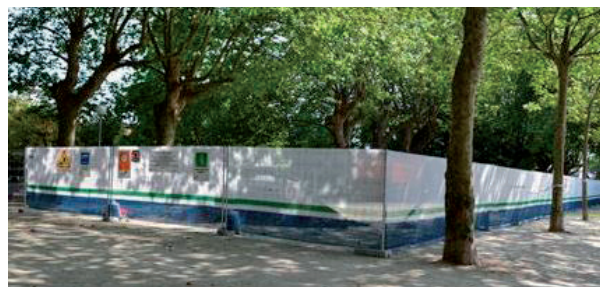
> Una correcta señalización y vallado de la zona de trabajo contribuye a que tanto el personal de FCC Construcción como otros agentes implicados en las obras (subcontratas o proveedores) estén informados de las normas y prácticas existentes en materia de medio ambiente.
