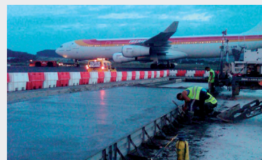
Ejecución de losas de HP45.
