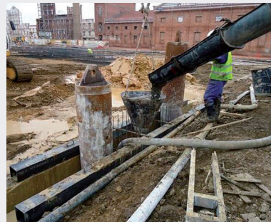
Colocación de tubos previo al hormigonado del muro pantalla.
