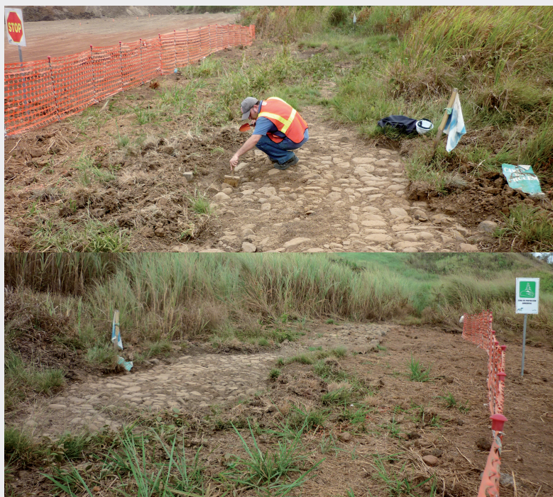
Tareas de protección y restauración del “Camino de Cruces”.
