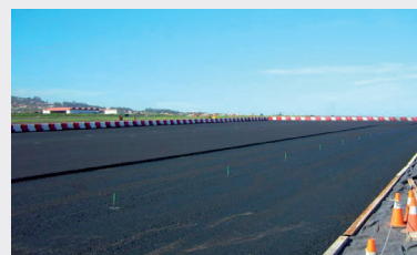
Ejecución de aglomerado asfáltico.
