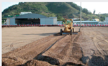
Extendido y nivelado de zahorra de hormigón machacado.
