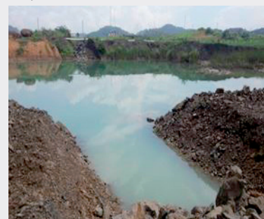
Vista de la balsa en su nivel máximo para el bombeo.
