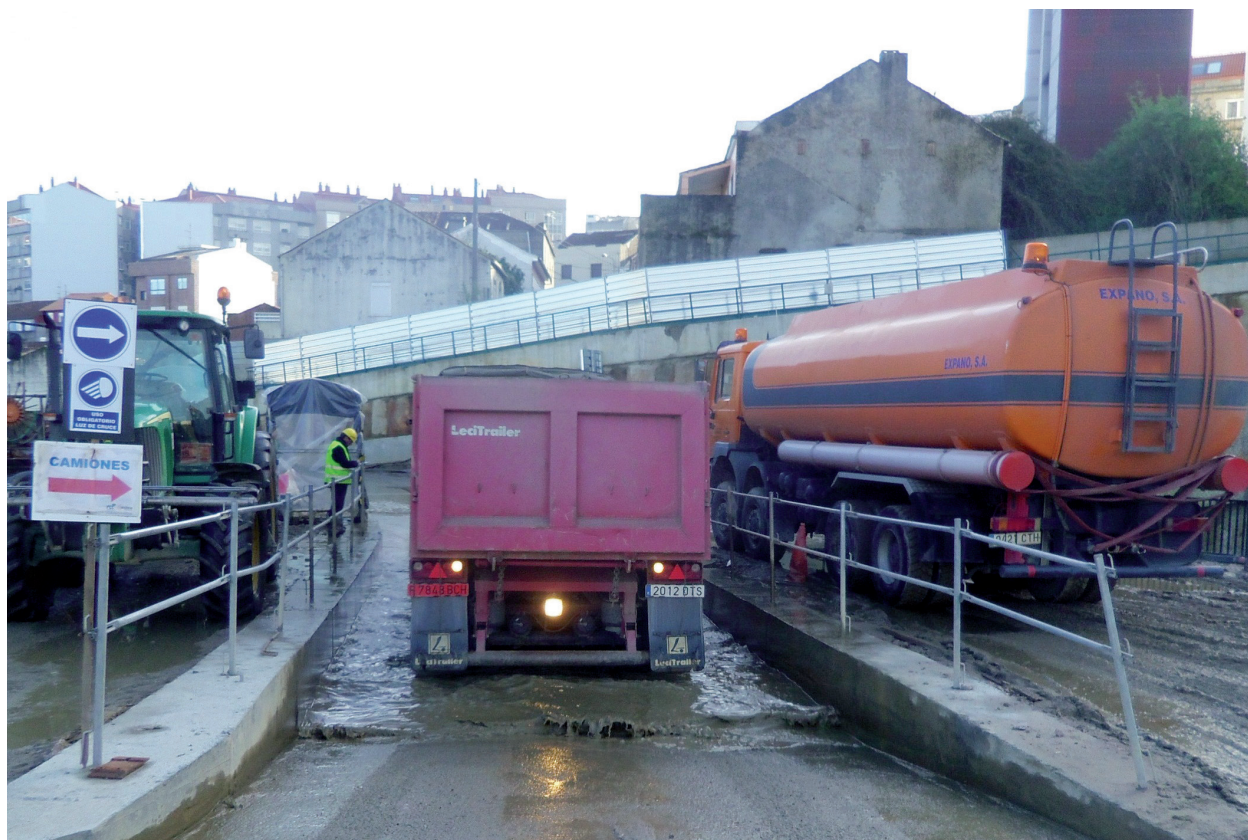
➤ El lavado de las ruedas de los camiones antes de su incorporación a vía pública evita el arrastre o dispersión de lodos y polvo en la misma, aspecto especialmente importante cuando la obra se localiza en un entorno urbano.
