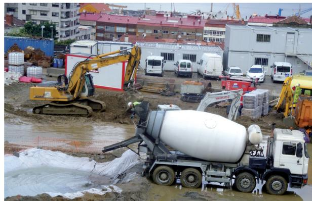
➤ Ejemplo de dos Buenas Prácticas relacionadas con los vertidos, implantadas en la construcción de la Nueva Estación de Vigo. Por un lado, instalación de una barrera temporal de balas de paja para evitar el aumento de turbidez en cauces de agua cercanos y, por otro, el vertido de las aguas de lavado de canaletas en una balsa acondicionada para tal fin previamente a su vertido al medio.
