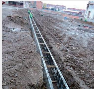
Ejecución del murete guía encofrado a una cara.
