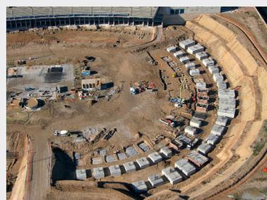
La solución final para realizar los encepados de cimentación fue realizar una zanja corrida para asegurar la correcta elaboración de los trabajos.
