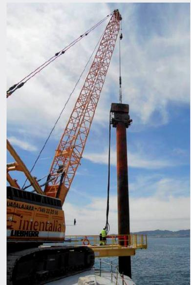
Vibrohincador hidráulico en el proceso de hincado de camisas perdidas.
