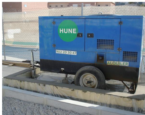
► Para prevenir daños provocados por el derrame accidental de combustibles, aceites u otras sustancias peligrosas, se procede a impermeabilizar la superficie en la que se va a alojar la maquinaria de obra, como es el caso del generador de la imagen.
