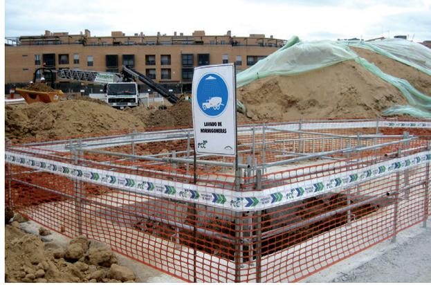
> El agua utilizada para el lavado de las canaletas de las hormigoneras se recoge en contenedores o balsas para neutralizarla antes de su vertido. De esta manera se reduce el pH de estas aguas y se cumple con la legislación específica o con la autorización de vertido.
