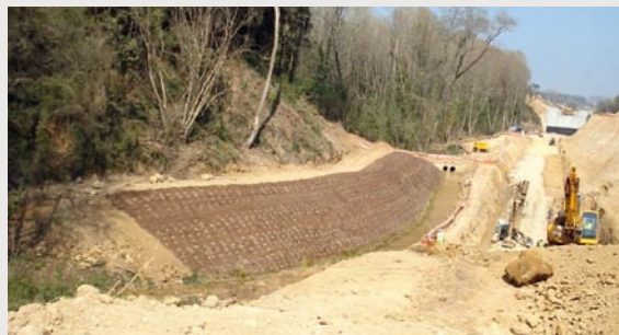
Protección del talud con geomallas.
