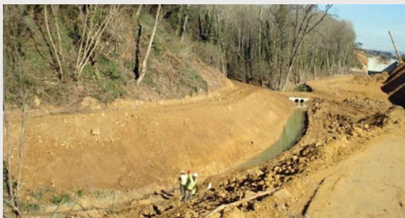
Talud del nuevo encauzamiento.
