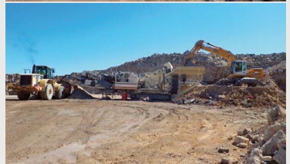
Valorización de RCDs en obra.
