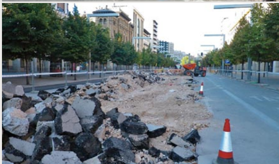
Demolición del pavimento.
