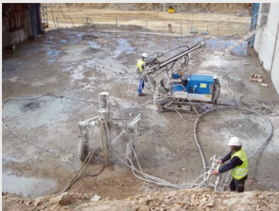
Maquina realizando taladros para inyecciones de consolidación
