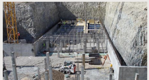
Ejecución de las plantas de sótano de las viviendas.
