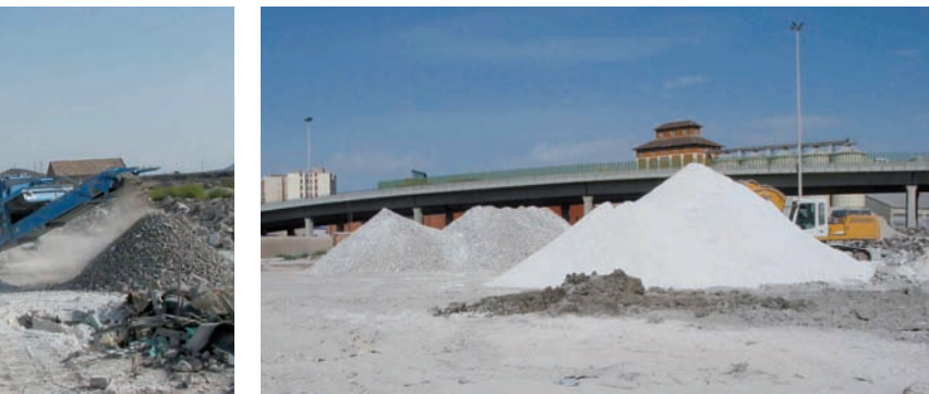
Una de las Buenas Prácticas adoptadas por FCC Construcción en el ámbito de los residuos es la valorización de escombros procedentes de demolición para formación de áridos que se emplearán como nueva materia prima.
