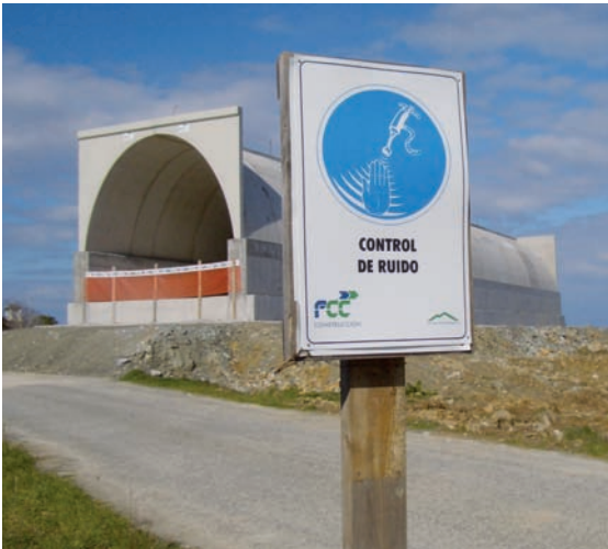
Se emplea señalización para identificar las áreas en las que el efecto del ruido generado por la actividad de la obra puede resultar especialmente molesto o en las que existe algún tipo de limitación, como la restricción de horarios, actividades o especial sensibilidad.
