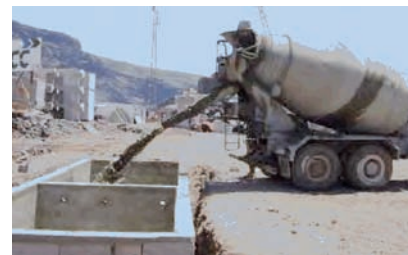
El uso racional del agua es una práctica elemental y sencilla de aplicar. No se trata de escatimar su consumo, sino de consumir estrictamente la cantidad necesaria. Esto se consigue, por ejemplo, con técnicas como la reutilización del agua de lavado de canaletas
