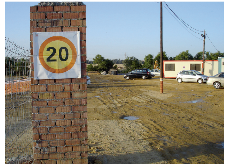
Una medida muy sencilla y altamente eficaz, tanto para la reducción de las emisiones de combustión, como para los niveles sonoros, es la limitación de la velocidad de los vehículos que circulan durante la ejecución de las obras.
