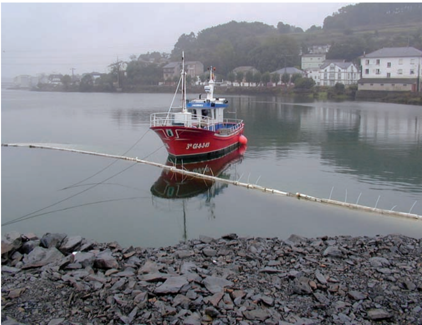
El empleo de pantallas de geotextil es un método muy eficaz para la separación de finos y, por flotación, de los aceites que puede llevar el agua en emulsión, previniendo de este modo la contaminación de las aguas próximas.
