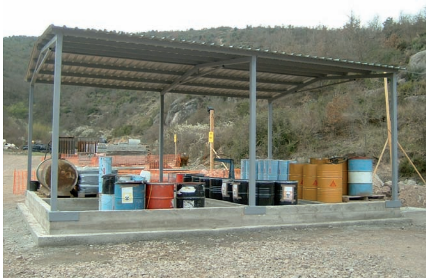
La disposición de cubetos, preferiblemente compartimentados, para el almacenamiento de sustancias o productos peligrosos centraliza el almacenamiento de los mismos en un solo punto y previene los vertidos o derrames accidentales que pudieran ocasionarse.
