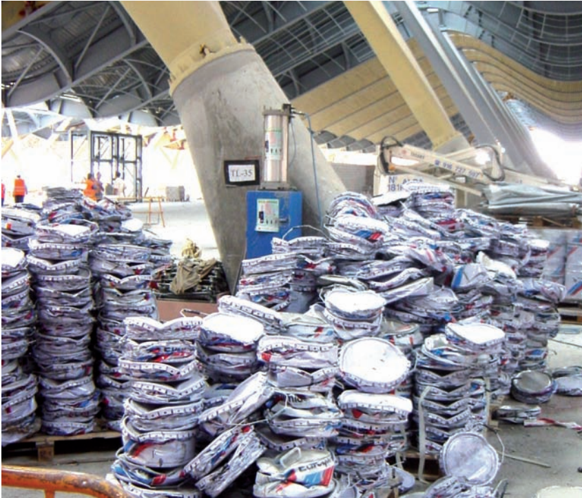
El empleo de medios para la compactación de los residuos generados (en el caso de la fotografía: botes de pintura) propicia la reducción del espacio ocupado por los mismos y del volumen a transportar. Con ello, el transporte de los residuos es mucho más eficiente y minimiza sus gastos económicos y ambientales asociados.
