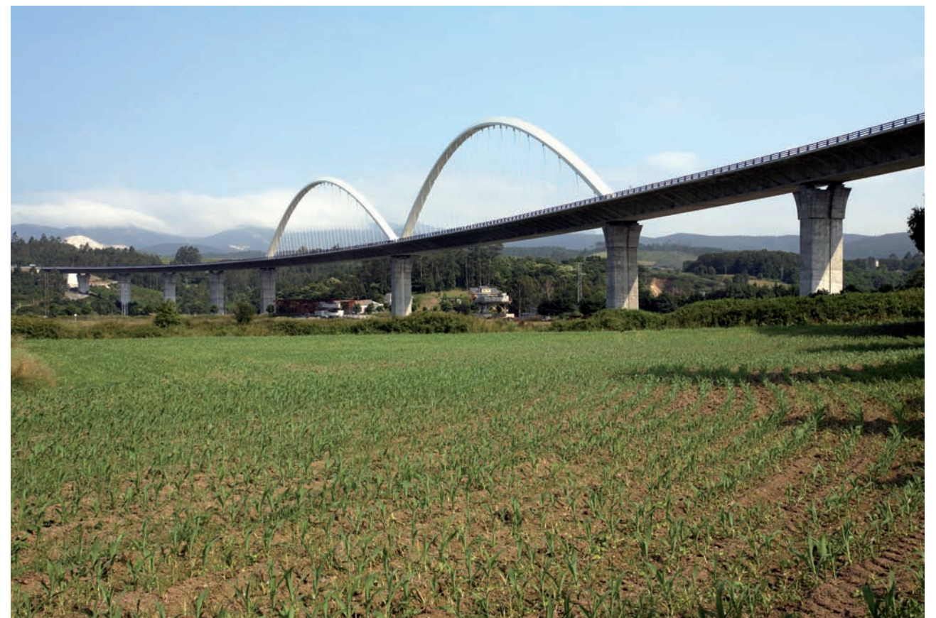
Las grandes infraestructuras suponen necesariamente un impacto sobre el medio natural, pero es posible paliar determinados efectos, como el efecto barrera, mediante pasos que permeabilicen el trazado y faciliten la comunicación entre las áreas resultantes.
