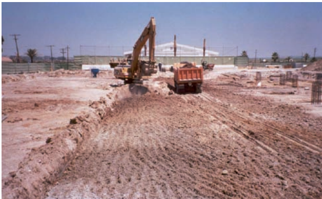
FCC Construcción cuantifica y registra el volumen de tierras contaminadas, tanto las de generación accidental propia como las ajenas a la obra y encontradas durante la construcción, llevando un control de las mismas y asegurando su correcta gestión, que va desde la retirada de las mismas, hasta la descontaminación de estas áreas, siempre dentro de los términos y plazos que establece cada Comunidad Autónoma.
