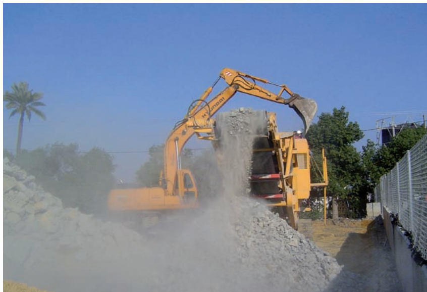
Las operaciones relacionadas con la edificación y la obra civil generan inevitables cantidades de polvo, que tratamos de minimizar en la medida de lo posible con actuaciones como riego de los caminos, escombros y acopios; reducción de la altura de vertido del material, empleo de trompas para el vertido de escombros desde altura, cubrición de la superficie de voladura o utilización de pantallas contra la dispersión del polvo, entre otras.
