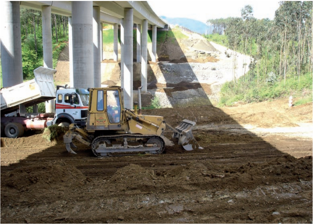
En la construcción se dan grandes movimientos de tierras, lo que hace precisa una adecuada planificación para poder reutilizar la tierra y áridos extraídos en la misma obra, disminuyendo de esta forma los costos económicos y medioambientales.
