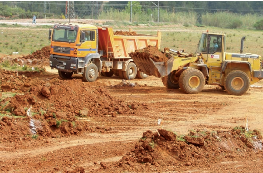
La tierra vegetal, cuya última finalidad es la reutilización en la propia obra, se almacena en un lugar exclusivo y delimitado, evitando la contaminación con otros residuos y volteándola periódicamente para garantizar la implantación de la futura cubierta vegetal.
