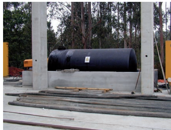
FCC tiene identificadas las situaciones potenciales de emergencia y riesgo de accidentes que puedan tener impacto en el medio ambiente y ha desarrollado toda una dinámica procedimentada para responder ante los mismos.
