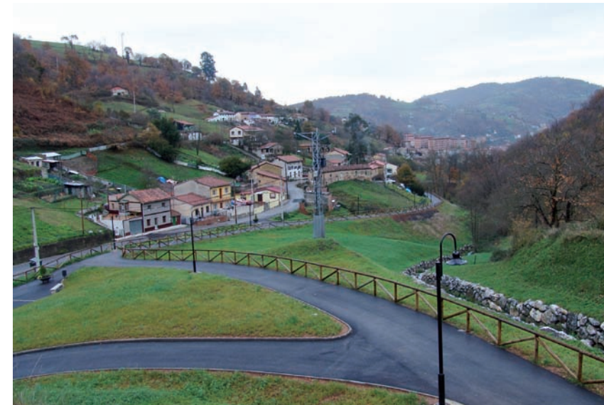
Es importante conocer la situación y características principales de los cauces de aguas cercanos al desarrollo de las obras para poder, desde el inicio, prevenir una posible contaminación de los mismos. Una vez evaluada la naturaleza del medio receptor y de la obra ejecutada, desde FCC Construcción se planifican las Buenas Prácticas más adecuadas para afectar lo menos posible la dinámica del ecosistema en el que realizamos nuestro trabajo.
