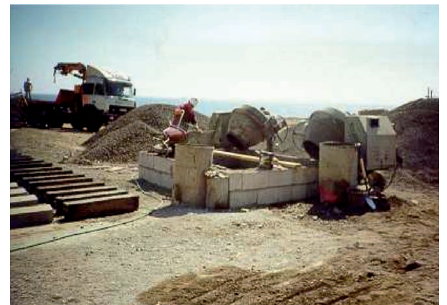
El agua producto de la limpieza de cubas de hormigón u otros lavados tiene un pH muy básico, por lo que hay que neutralizarla antes de su vertido. Una alternativa ecoeficiente es el empleo del agua de lavado en el propio proceso de fabricación de nuevo hormigón, minimizándose a su vez el consumo de agua.
