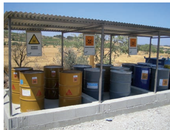
Los RPs se depositan en cubetos adecuadamente impermeabilizados, compartimentados y señalizados.
