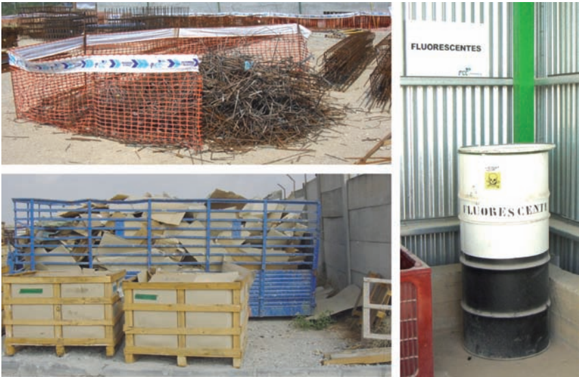
En función de los residuos generados en las obras, se establecen zonas diferenciadas para la recogida de los mismos, tanto si son residuos peligrosos, como si no lo son. De este modo se sistematiza y facilita el posterior tratamiento. Las ilustraciones adyacentes muestran una zona de recogida de restos de ferralla, una zona de recogida de cartones y un bidón acondicionado en el que se acopian los fluorescentes usados
