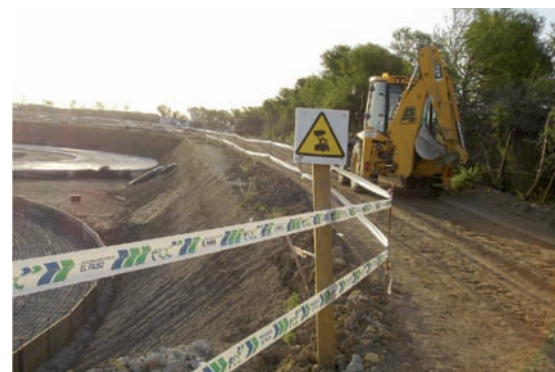
Es importante la delimitación de las áreas de acceso y ocupación, señalizando la entrada y salida de vehículos propios de la obra y externos. Se utilizan preferentemente caminos existentes antes de abrir nuevas vías y en los casos en que no es posible se trazan de modo que se cause el mínimo impacto visual y puedan tener un uso alternativo en el futuro, como pista forestal, por ejemplo.
