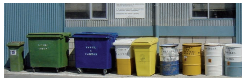
Para separar y almacenar la gran diversidad de embalajes que se concentran en la obra es necesario reservar un espacio específico. Su gestión pasa por la entrega, bien al sistema de depósito, devolución y retorno o al sistema integrado de gestión, si están sometidos a alguno de los mismos, o bien a un agente económico para su recuperación, reciclaje o aprovechamiento energético.
