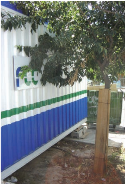
A la hora de proteger físicamente ejemplares vegetales se evitará colocar cuerdas, cables, cadenas, clavos, clavijas, etc., en los árboles, sin la protección adecuada, así como almacenar cualquier tipo de residuo en las áreas de vegetación
