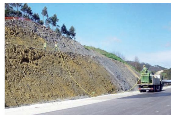
Mediante operaciones como la hidrosiembra se restauran áreas cuyo valor ambiental haya podido verse disminuido por las instalaciones y actividades de la obra, adecuando el terreno afectado morfológica y paisajísticamente e integrándolo con el entorno circundante.
