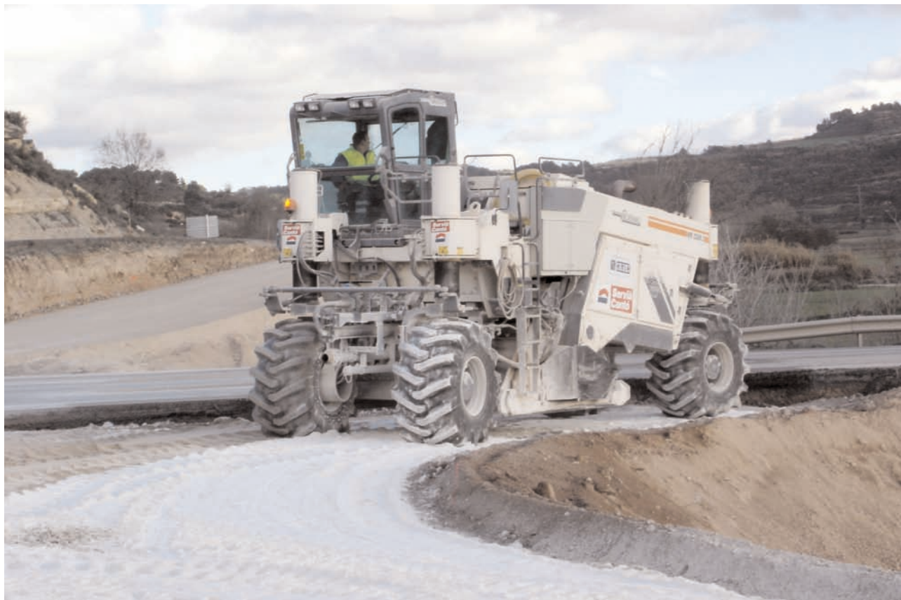
La estabilización de las tierras, con empleo de cal o cemento, evita la necesidad de su vaciado, de forma que se disminuye la cantidad de residuos generados y la necesidad de recursos consumidos, optimizando la gestión de los mismos.
