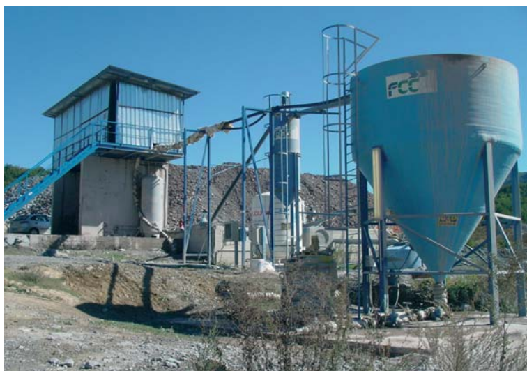
En obras con efluentes importantes, como pueden ser los túneles, se montan en ocasiones dispositivos de depuración más sofisticados para neutralización de pH, decantación, secado de fangos, etc., para satisfacer requisitos de calidad superiores a los exigidos
