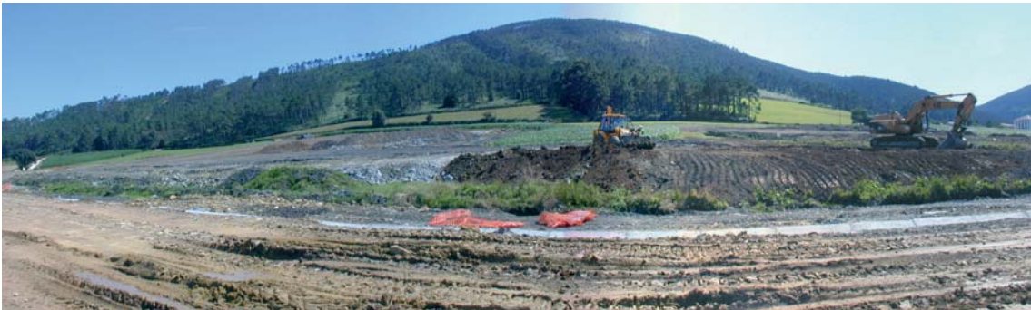
La tierra vegetal es un recurso escaso y valioso que debemos intentar reutilizar en las propias obras. Los excedentes no deben ser llevados a vertedero, sino aprovecharse en la propia obra, o bien emplearse para la mejora de terrenos adyacentes
