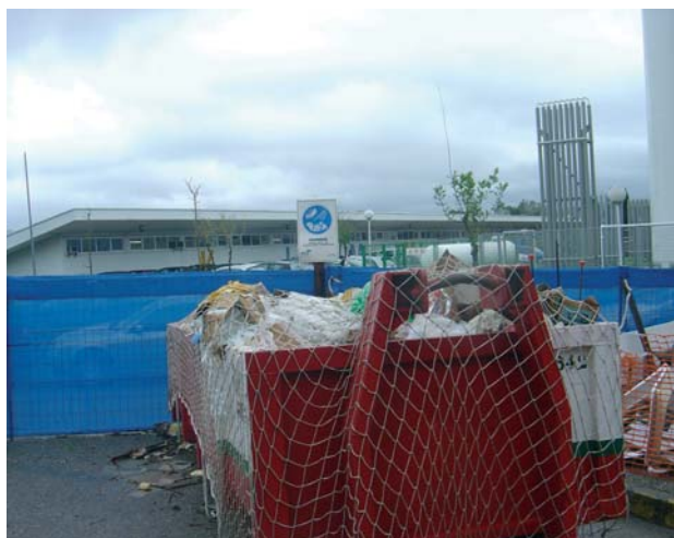
Una clara señalización de los contenedores, una protección de los contenidos de los mismos frente a la disgregación por viento, una clasificación adecuada por categorías, permite un mejor y más eficaz aprovechamiento de los mismos
