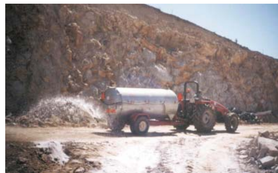
Una operación tan sencilla como el riego posee una extraordinaria eficacia frente a la generación de polvo en las obras, lográndose sólo con el agua reducciones próximas al 80% de las partículas en suspensión
