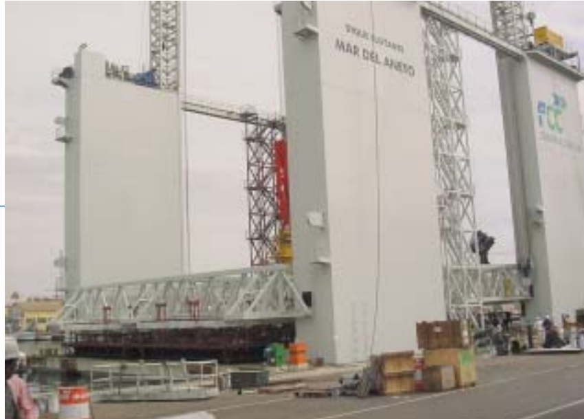
La prefabricación de determinados elementos fuera del medio natural en que se enclavan finalmente supone la reducción de riesgos de contaminación por accidente o incluso del mismo proceso constructivo, como la prefabricación de cajones de hormigón para muelles portuarios en diques flotantes
