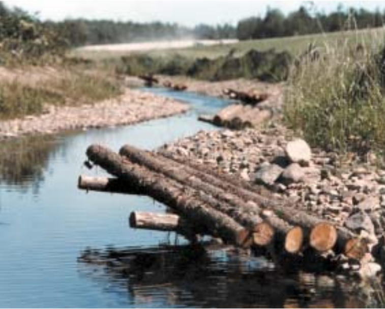
La vegetación de ribera cumple funciones de resguardo, sombra y frezadero que deben ser suplidas artificialmente en ocasiones, cuando la ejecución de las obras exige su eliminación temporal, mediante dispositivos que permitan mantener en el ecosistema determinada calidad biológica
