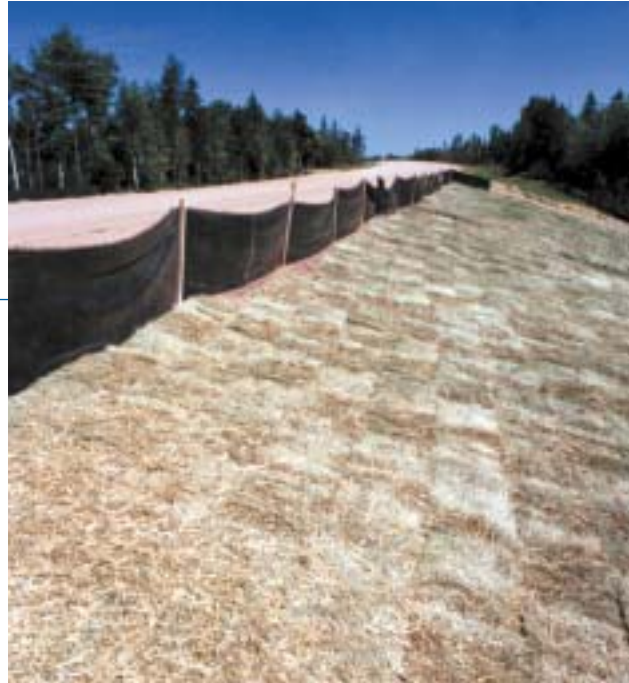
Las plantaciones en las laderas artificiales (terraplenes y desmontes) o naturales próximas a nuestras obras se hacen con las máximas garantías, buscando pendientes adecuadas y protegiendo con mulches, como en la figura, la hidrosiembra realizada
