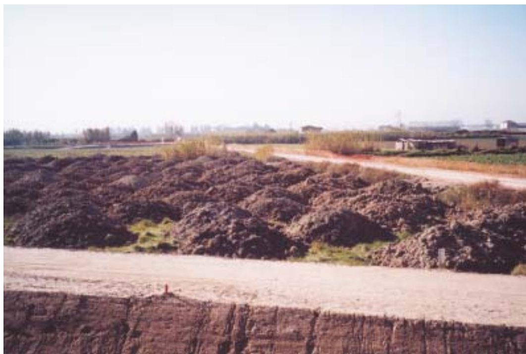
La tierra vegetal debe separarse convenientemente para su posterior reutilización en labores de restauración. En ocasiones, además, es preciso diferenciar distintos tipos y calidades para conseguir una adecuada reposición de la situación anterior, lo que lleva a marcar las áreas de generación y los acopios de acuerdo con sus características
