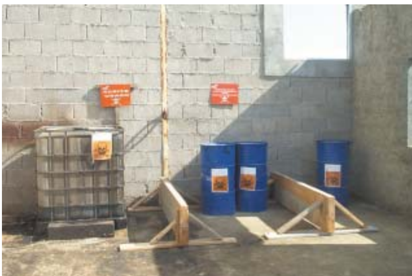
Para las sustancias peligrosas se considera esencial un correcto almacenamiento, la señalización adecuada, la preparación de planes de emergencia frente a eventuales accidentes, la planificación de su uso evitando su degradación o salida de especificaciones que las conviertan en residuos, y la adopción de medidas para evitar su mezcla o el incremento de su peligrosidad
