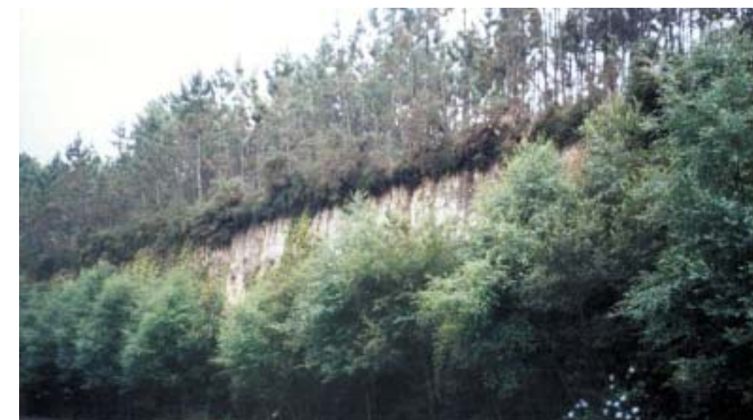
Las plantaciones arbóreas, frente a taludes verticales rocosos en los que la revegetación es poco menos que imposible, constituyen una buena solución para su integración en el entorno
