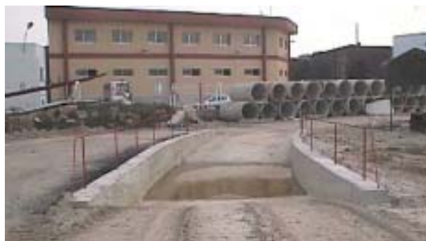
El impacto producido por la suciedad y los barroes en vías públicas se combate mediante la limpieza de los bajos de los camiones, la cubrición con lonas de las cargas, el lavado de ruedas en la salida, al pasar por un foso con agua
