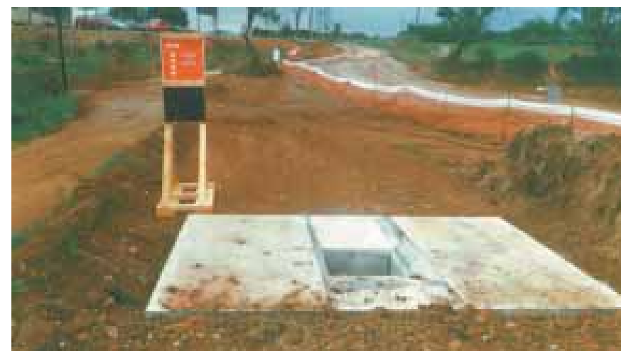
La creación de plataformas para el cambio de aceite evita una posible contaminación del suelo por hidrocarburos, en el caso de un vertido accidental (EDAR de Tarrasa).
