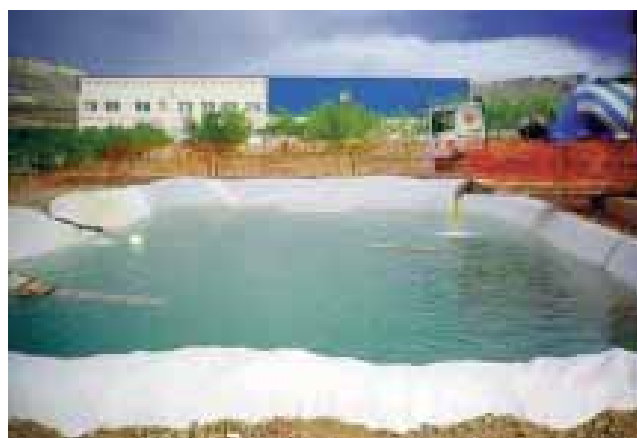
El agua procedente del lavado de cubas y canaletas se reutiliza, en las obras del tramo del AVE Calatayud – Ricla, para las siguientes amasadas de hormigón, tras una decantación.
