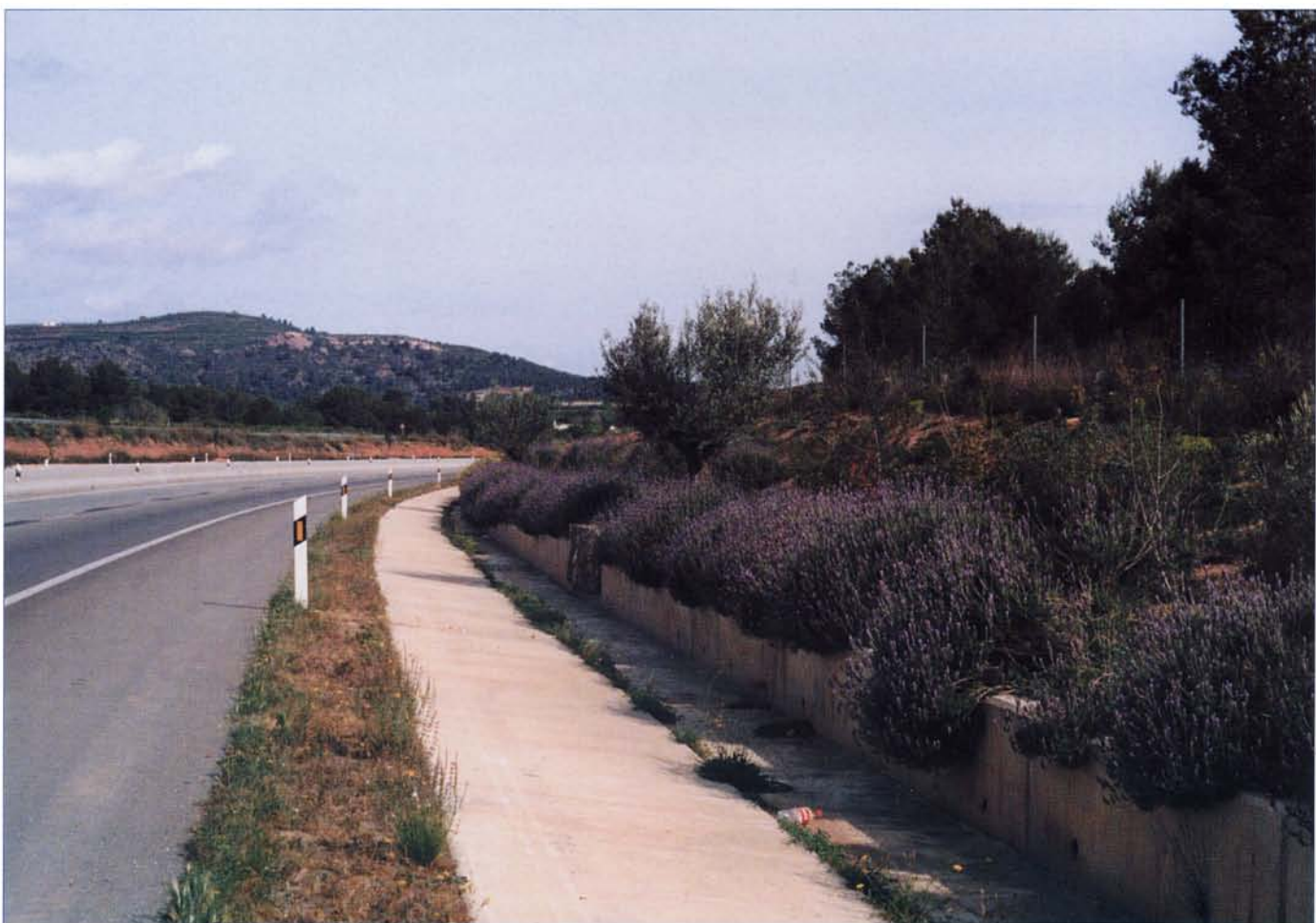
La solución de murete corrido junto a la cuneta retiene las aguas de escorrentía en los desmontes facilitando la colonización de los taludes por parte de la vegetación autóctona
