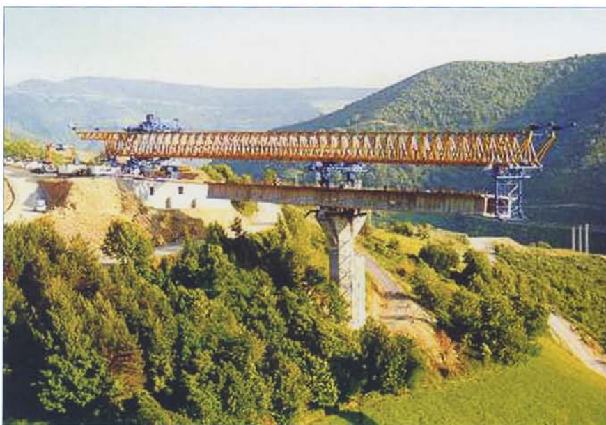
Las técnicas de ejecución de viaductos con vigas de lanzamiento permiten respetar la vegetación de la banda inferior de los mismos sobre el terreno natural.
