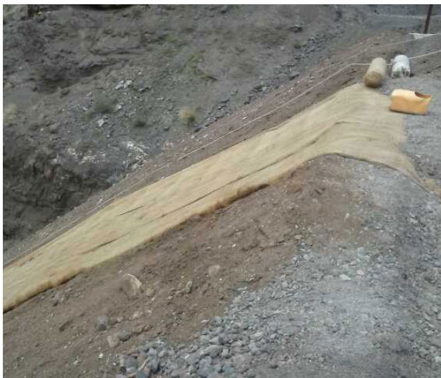
Colocación de los rollos de geotextil
