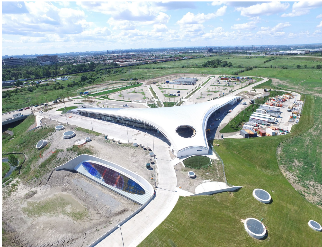
Estación de Autobuses y Metro. Toronto, Canadá.
