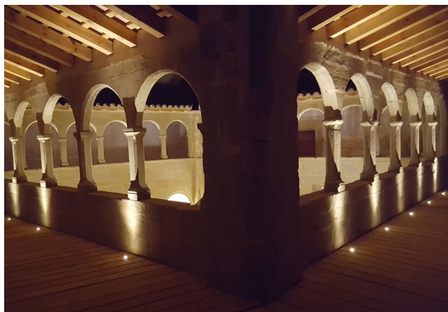
Rehabilitación del monasterio Riudeperes, Cataluña, España.
