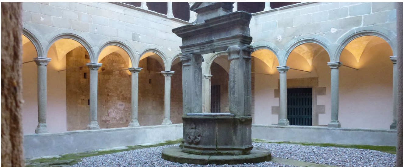
Rehabilitación del Monasterio Ruedeperes, Cataluña, España.
