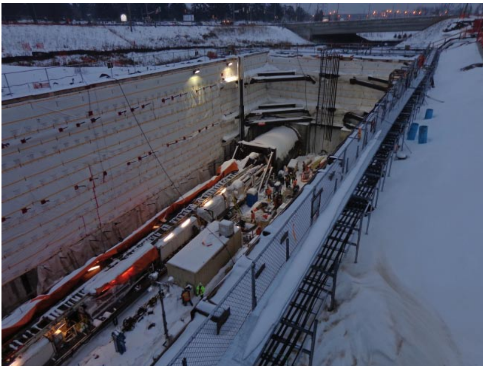
Obras del Metro de Toronto, Canadá
