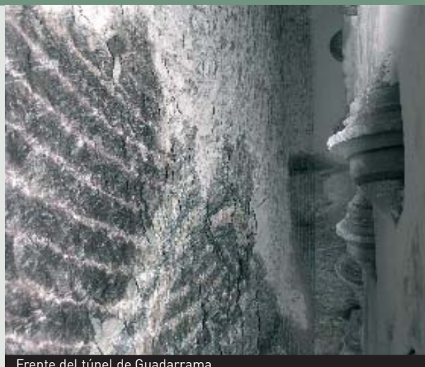
Frente del túnel de Guadarrama
