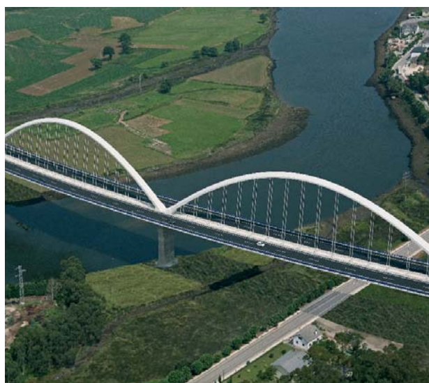
VIADUCTO DE NAVIA
