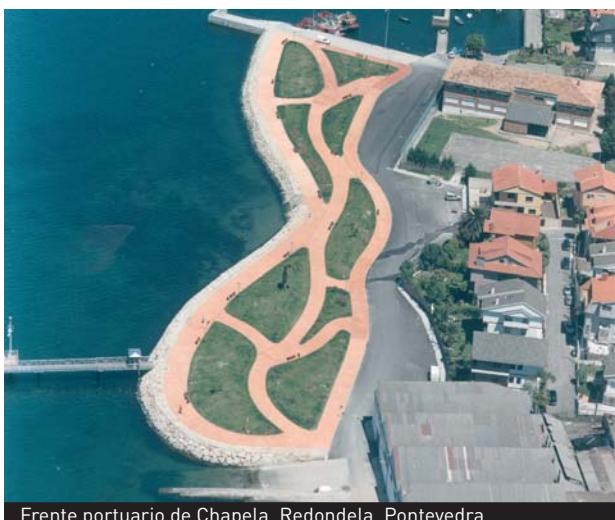
Frente portuario de Chapela. Redondela, Pontevedra
