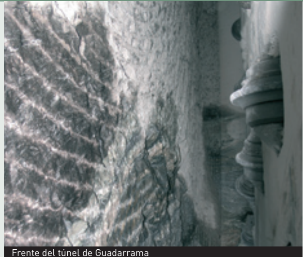
Frente del túnel de Guadarrama
