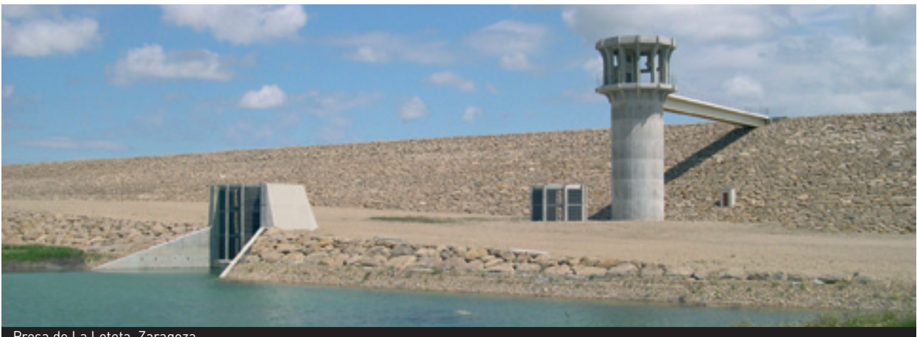
Presas de La Loteta, Zaragoza
