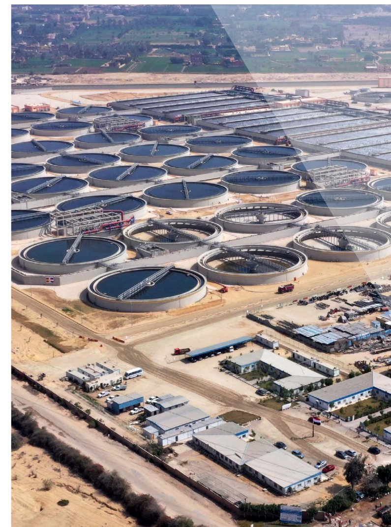
Stația de epurare a apelor uzate Abu Rawash (Egipt)
