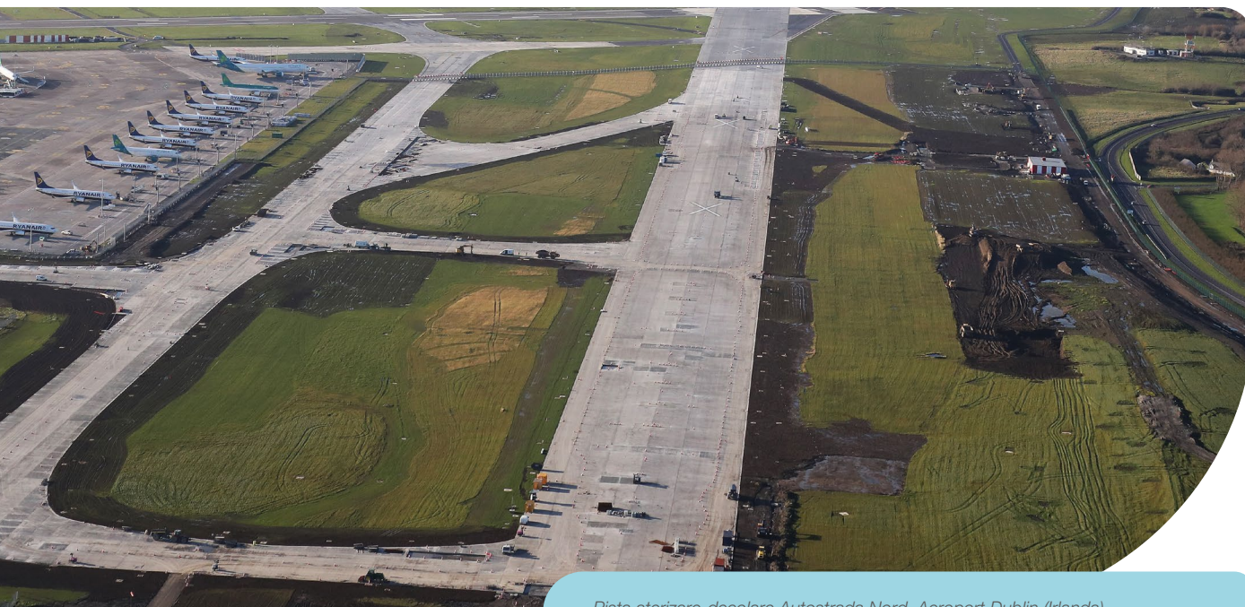
Pista aterizare-decolare Autostrada Nord, Aeroport Dublin (Irlanda)
