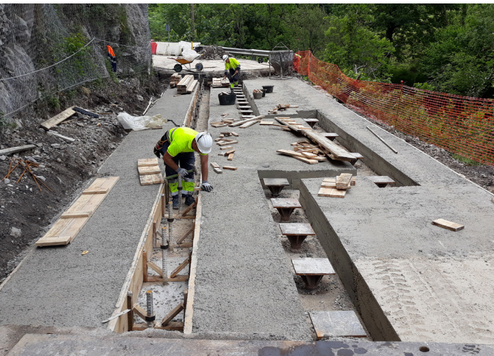
Obras de reparación de la carretera del Pontón en Asturias (España)
