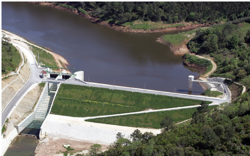
Presa Obidos (Portugal)
