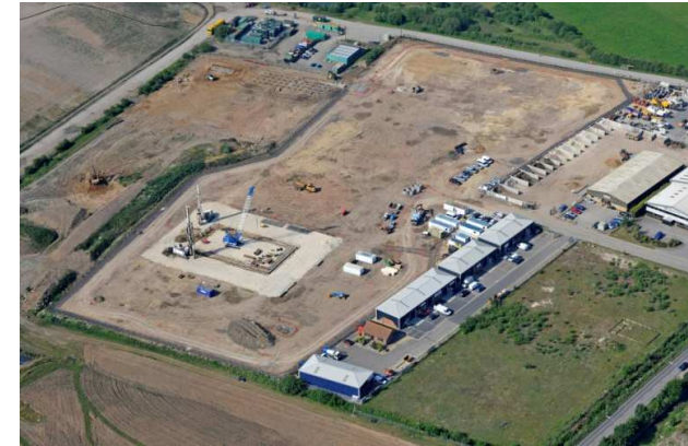
Inicio de obras (Junio 2011)
