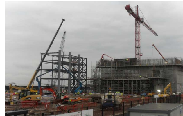
Avance de construcción (Febrero 2012)
