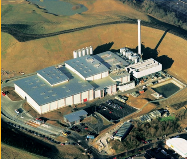
Planta de tratamiento térmico de residuos. Alington. Reino Unido
