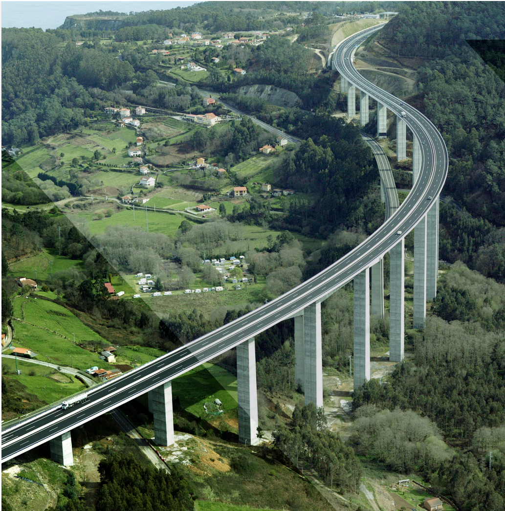
Autovía del Cantábrico, A-8 (España).
