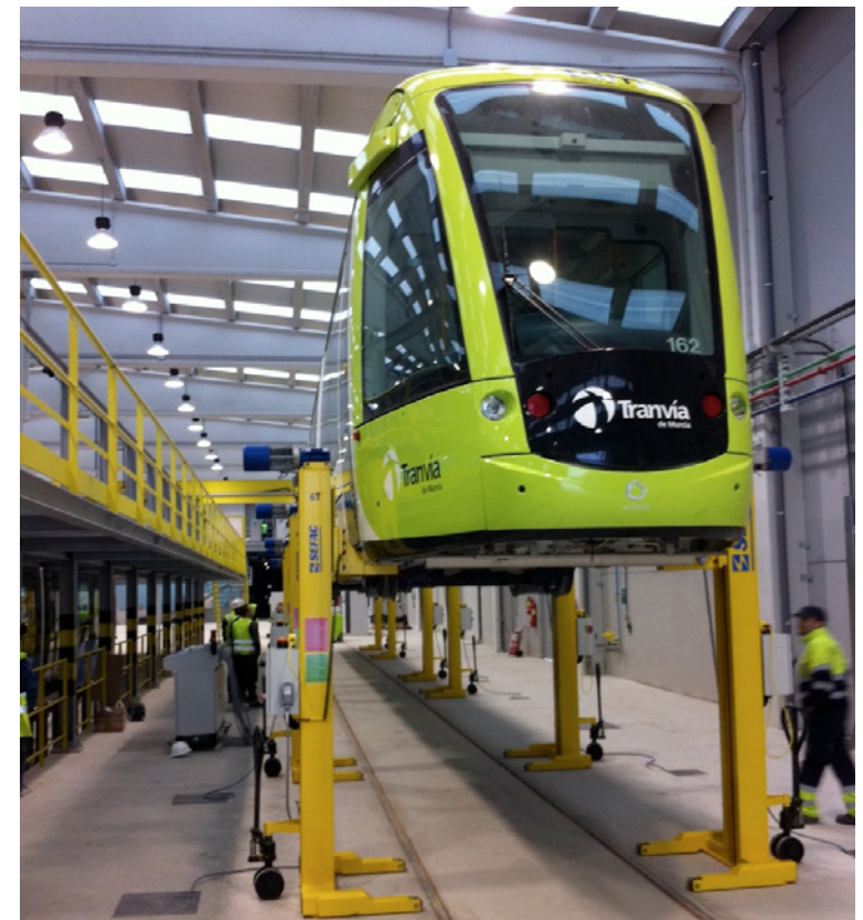
Taller de mantenimiento de tranvías
