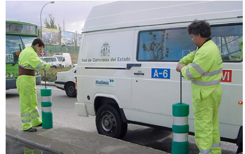
Colocación de bolardo flexible
