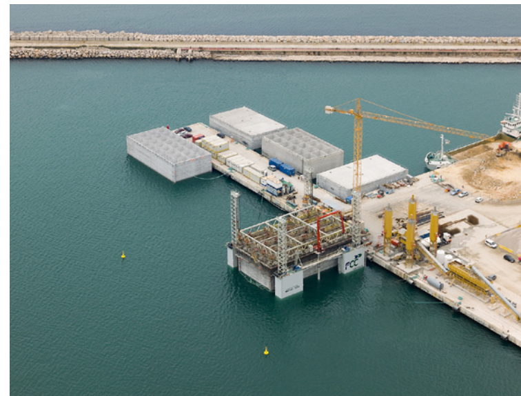
Muelle de la Química, Tarragona
