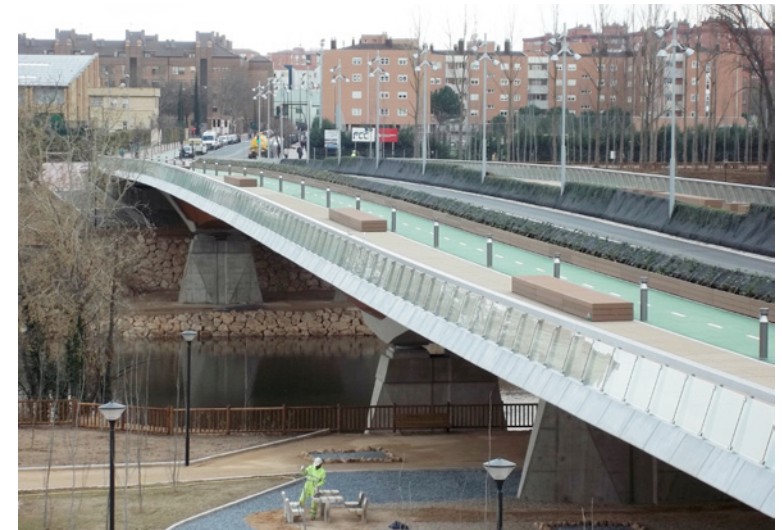
Puente sobre el río Pisuerga, Valladolid
