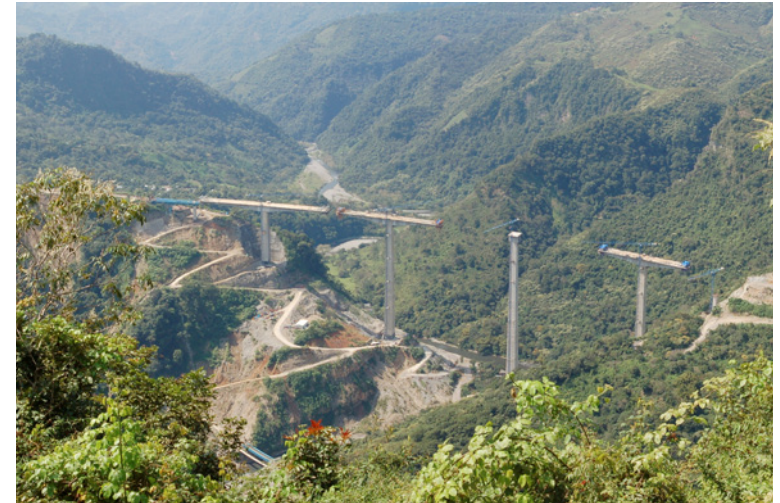
Viaducto de San Marcos, México
