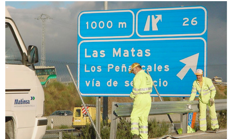
Instalación de barrera metálica
