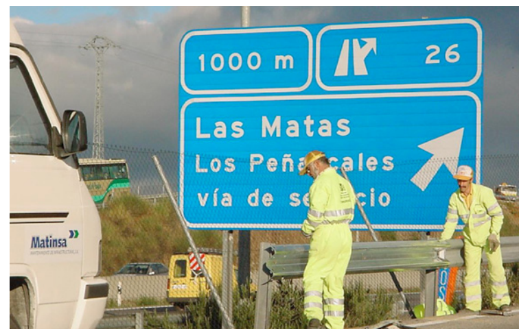
Instalación de barrera metálica
