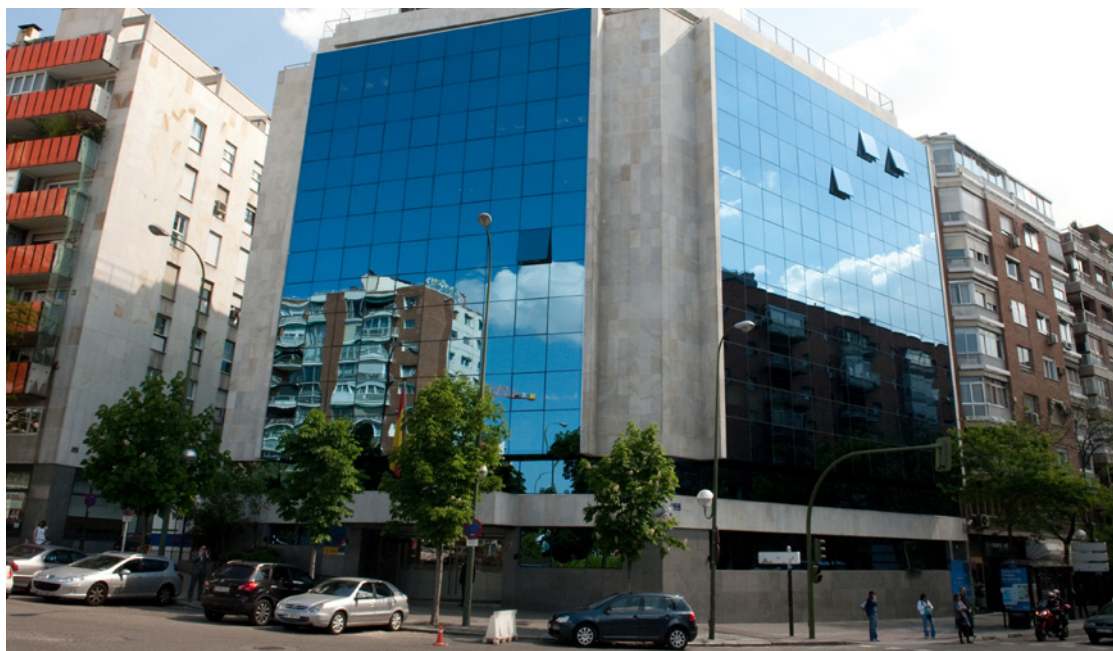
Rehabilitación de la sede de la Dirección General de Infraestructuras Ferroviarias, Madrid
