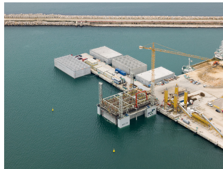
Muelle de la Química, Tarragona
