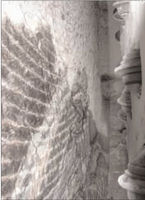
SE HA EMPLEADO UNA TUNELADORA mixta de doble escudo, con un diámetro de excavación de 9,5 m en el lado oeste y 9,46 en el lado este. En la foto, frente del túnel y detalle de la cabeza de la tuneladora.
